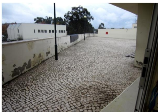
Figura n.º 72 – Varanda
