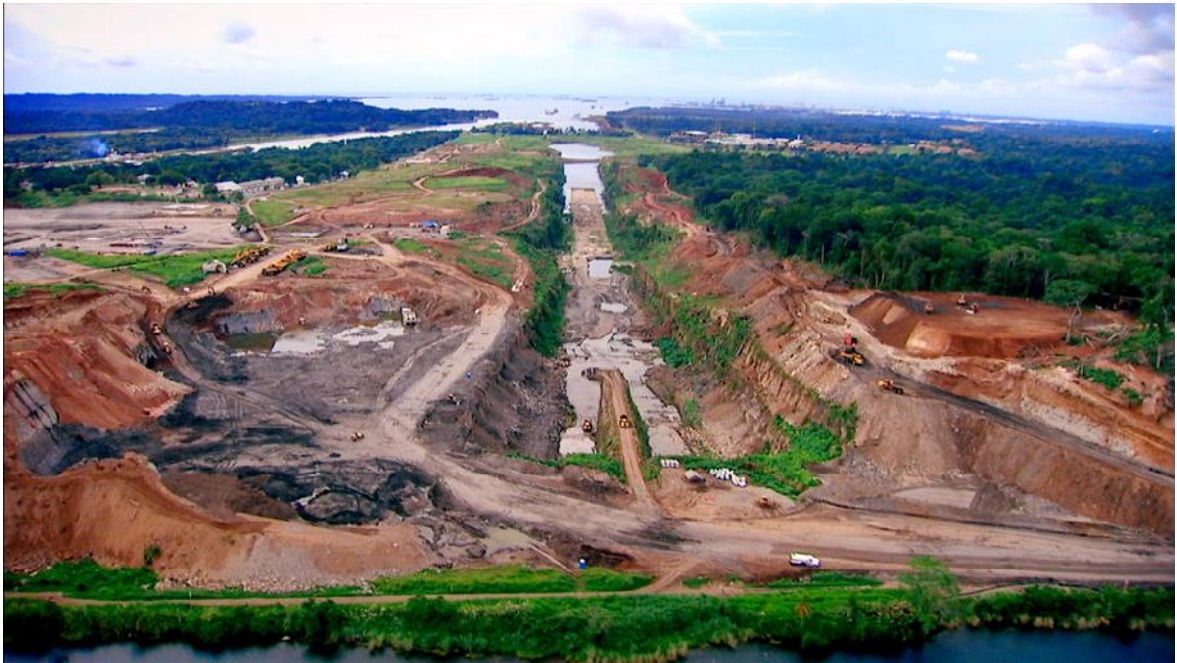
Figura nº 11 – Obras do alargamento do Canal do Panamá
