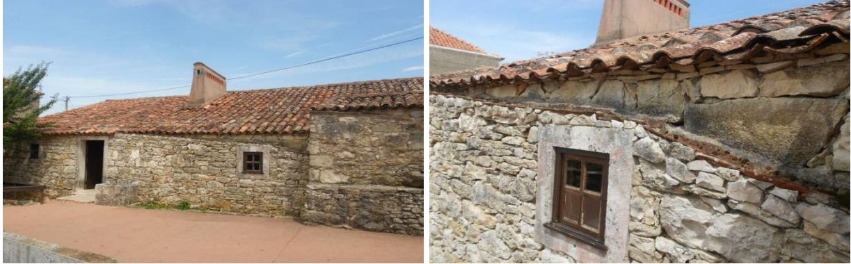
Figura A92 – Pormenor da caleira das águas pluviais no alçado posterior
