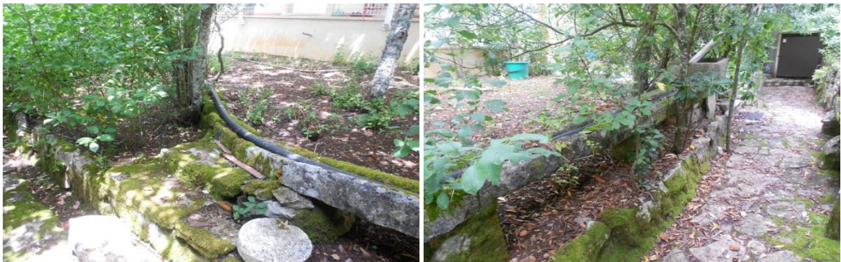
Figura A176 – Encaminhamento de águas pluviais no pátio com caleira em pedra antiga
