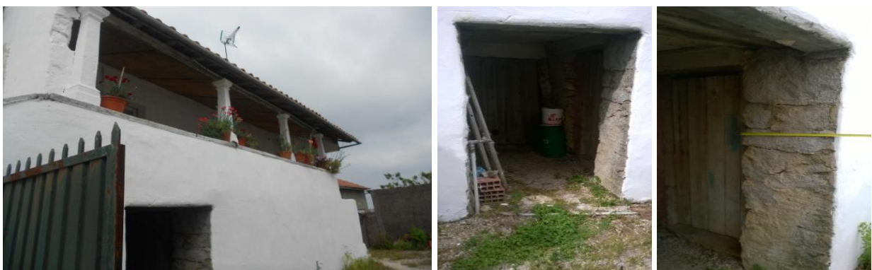
Figura A9 – Acesso ao armazém existente na fachada lateral
