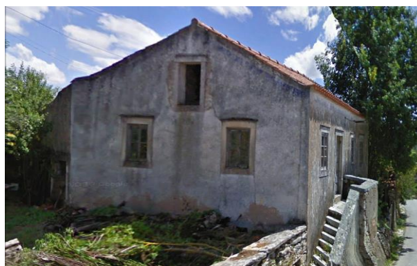
Figura A13 – Aspeto do edifício no ano de 2009
