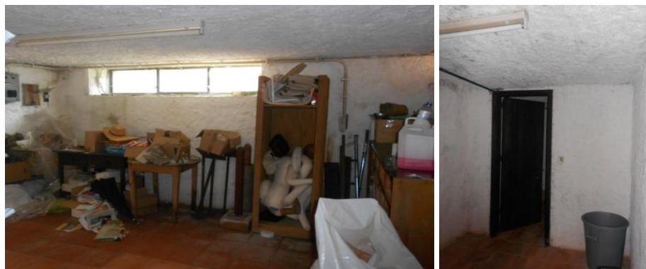
Figura A42 – Arrecadação (cave), acesso às instalações sanitárias
