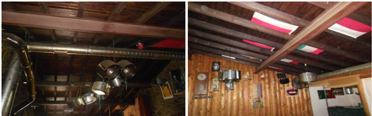
Figura A210 – Vista interior da cobertura
