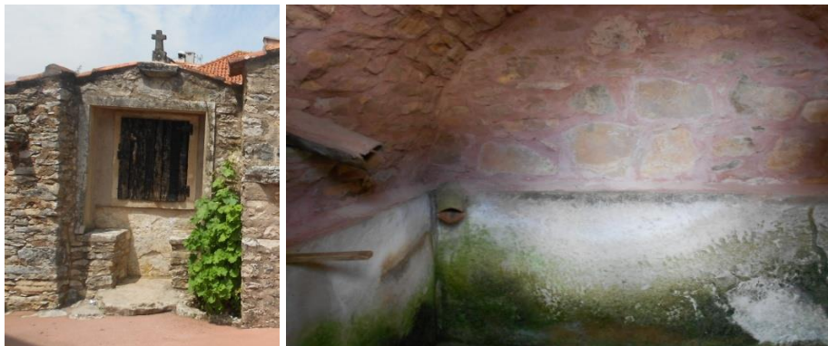
Figura A93 – Cisterna no pátio para aproveitamento das águas pluviais
