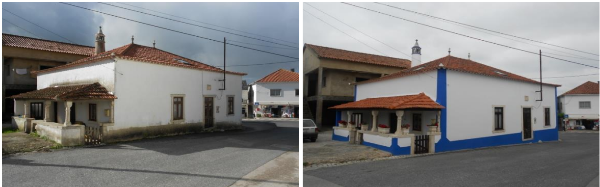
Figura A23 – O edifício em 2014, antes e depois de uma manutenção geral
