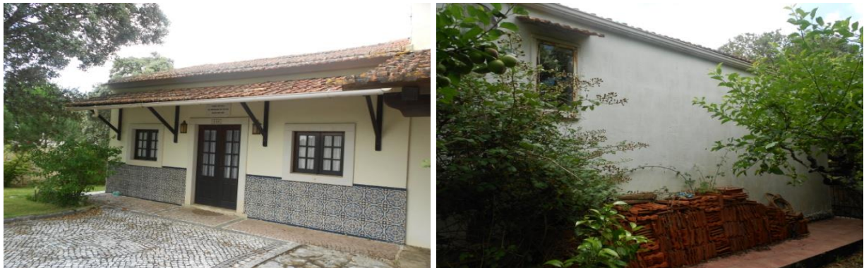
Figura A223 – Entrada e fachada posterior da capela
