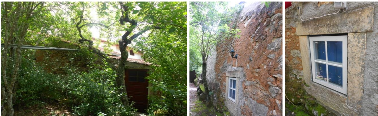
Figura A224 – Alçado lateral esquerdo, pormenor da cantaria da janela da cozinha
