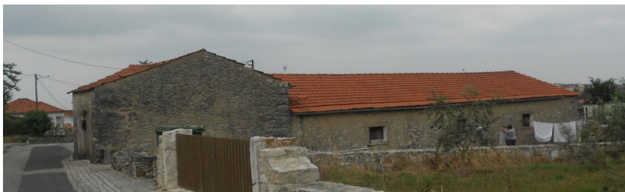
Figura A104 – Ligação com edifício adjacente
