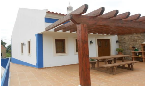
Figura A162 – Vista do telheiro e do alçado lateral esquerdo
