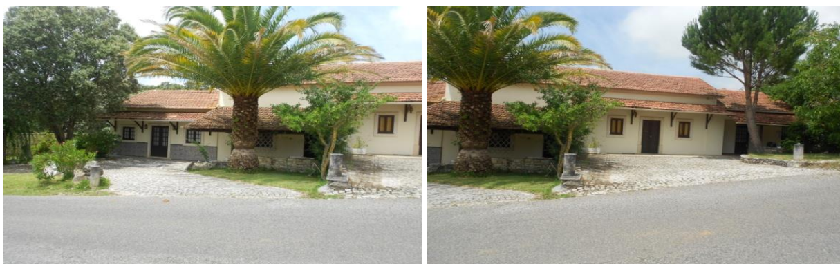
Figura A219 – Vista geral do alçado principal
