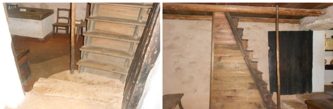
Figura A91 – Escadas na adega para acesso ao sótão
