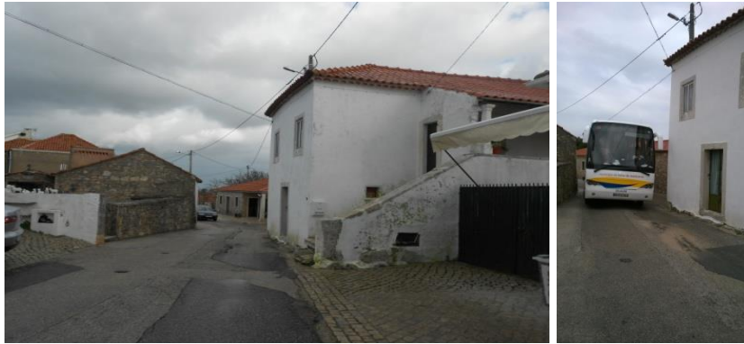
Figura A6 – Estrangulamento da via em frente ao edifício
