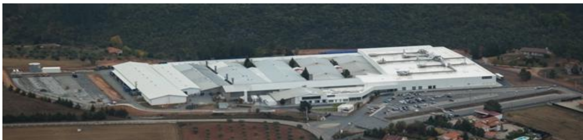
Figura 1.1 - Vista Aérea Atual da Faurecia Bragança
