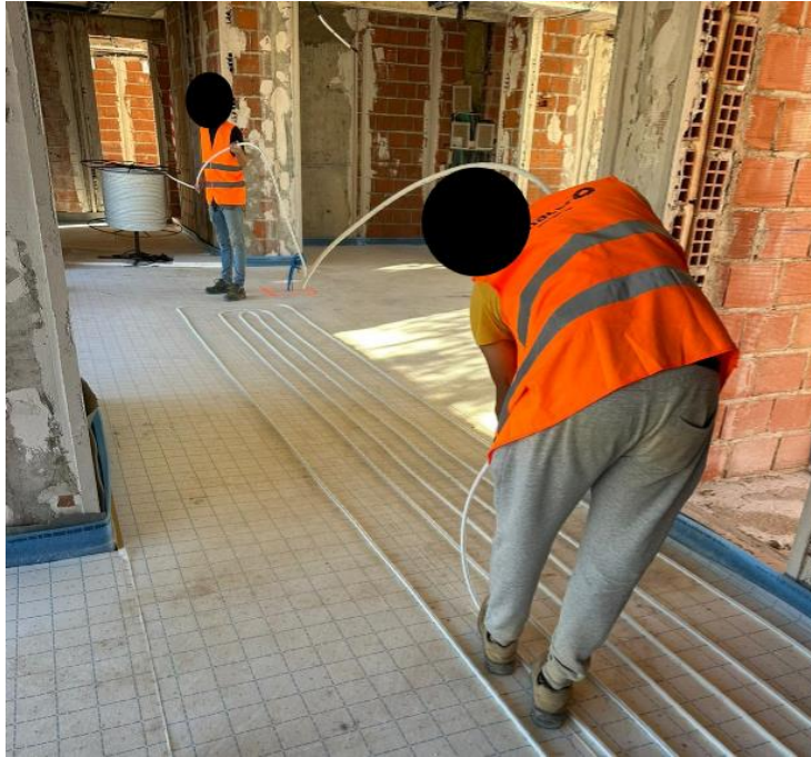
Figura 70 - Colocação de tubagem no sistema de pavimento radiante
