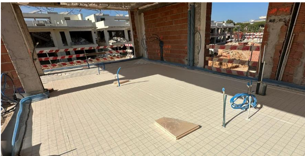
Figura 67 - Aplicação de painéis de fixação e de fita perimetral
