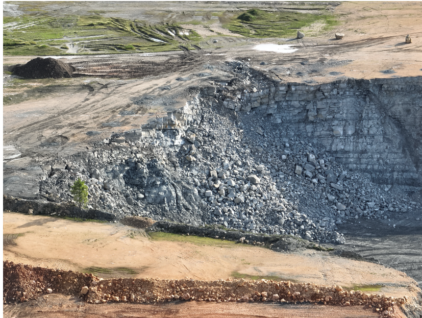
Figura 3.8 Desmonte na Pedreira
