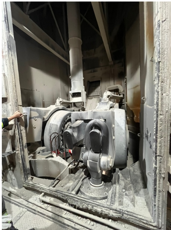
Figura 3.11 Interior do Moinho Vertical do Cru
