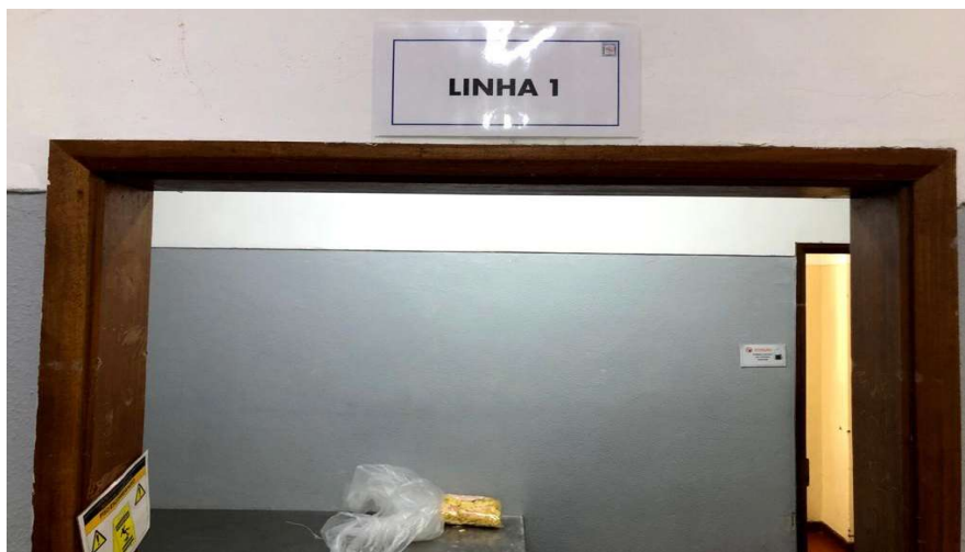
Figura 9 - Acesso à Linha 1 (Via Copa) - "O Depois"
