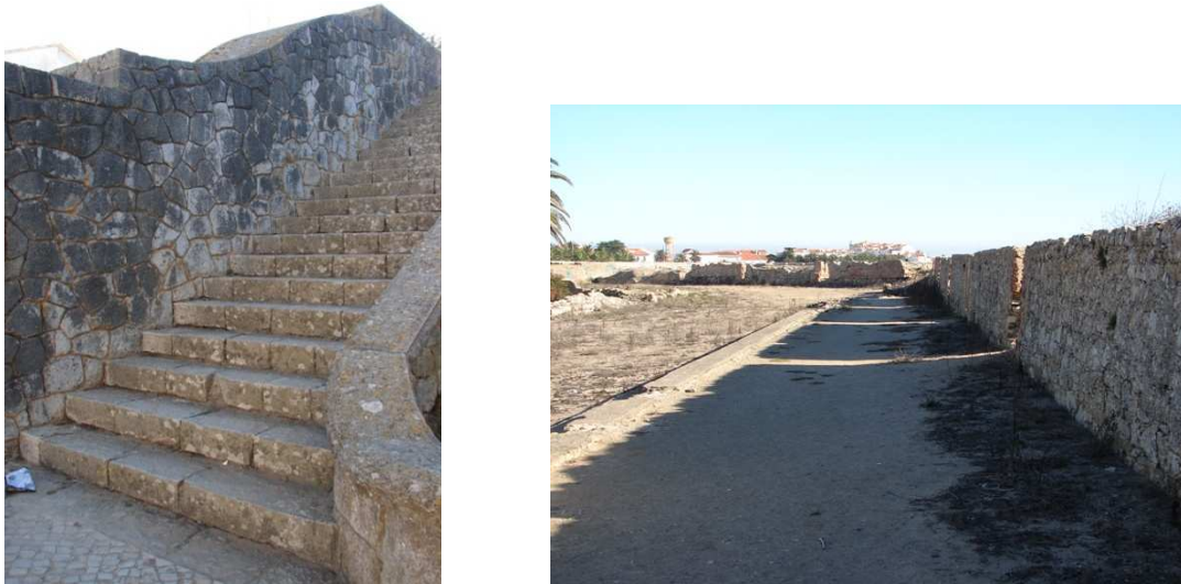
Figura 10 – Baluarte da Ponte: escadaria de acesso ao topo do baluarte (à esquerda) e vista parcial do antigo caminho de ronda (à direita).
