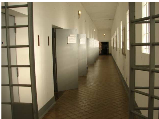
Figura 6 – O corredor das celas da prisão política, actualmente integrado no Museu Municipal.
