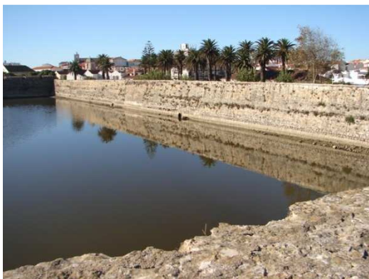
Figura 9 – Cortina do Morraçal ou do Jardim, vista a partir do lado exterior, com o fosso da muralha onde decorrem os trabalhos de limpeza e reordenamento.
