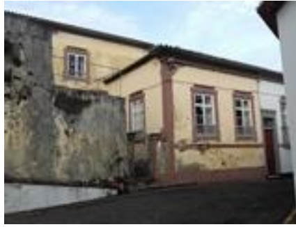
Figura 35: Rua de Cima de Santa Luzia 25. 28
