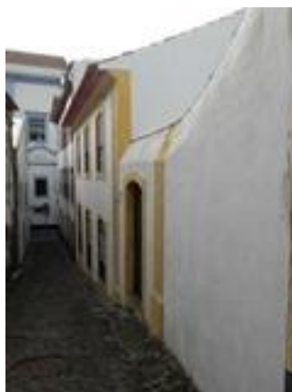
Figura 43: Edifício de habitação Rua do Faleiro. 30
