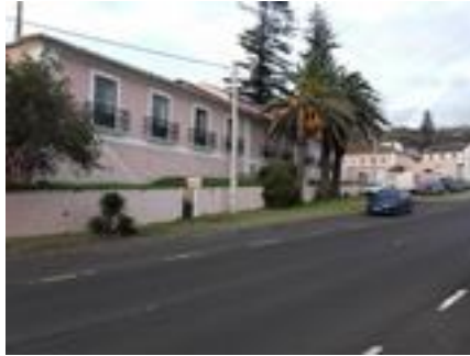
Figura 49: Edifício RTP Açores. 31
