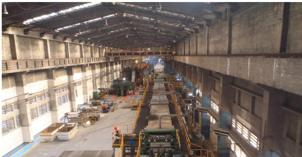
Figura 13 - Vista geral da nave industrial, que foi alvo de inspeção
