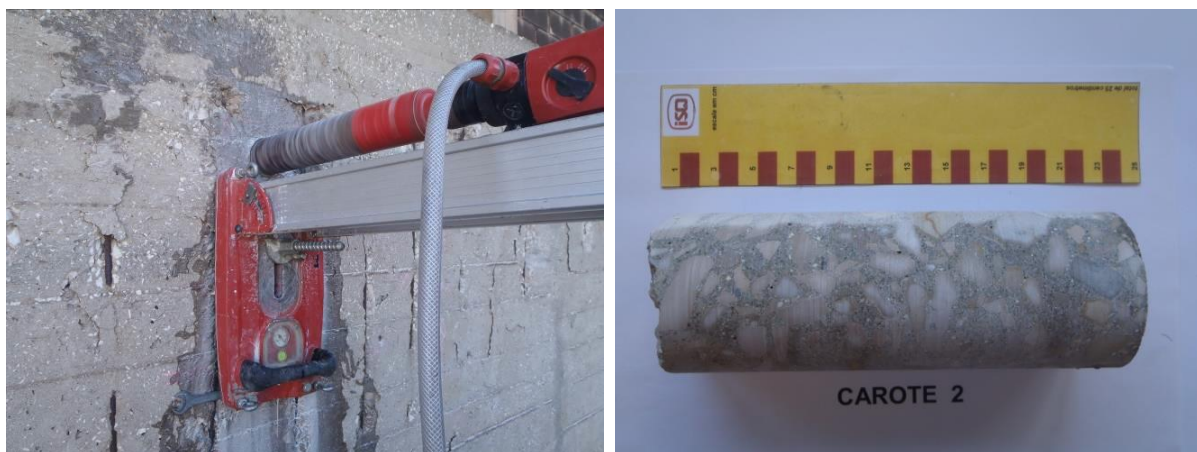
29A 29B Figura 29 - Extração de carote, na viga V2 – 29A; observação da carote C2, em laboratório – 29B
