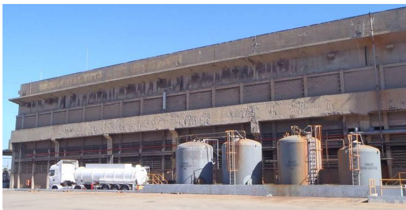
Figura 22 - Vista exterior do alinhamento B, onde se localizam os quatro reservatórios de ácido clorídrico
