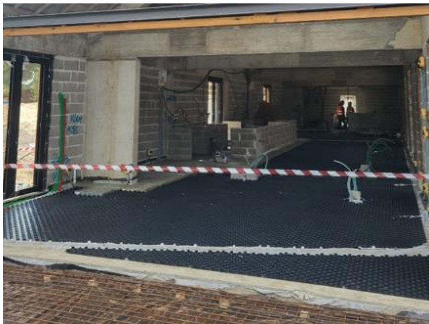
Figura 4.30 - Placas de isolamento para o piso radiante na zona das lojas
