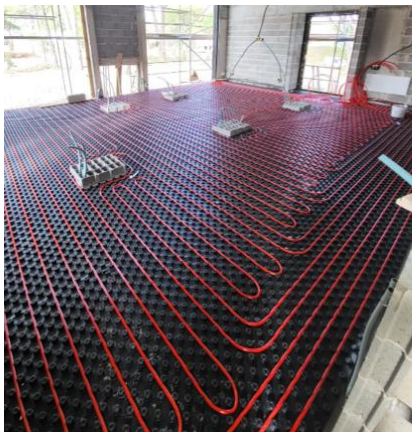
Figura 4.32 - Instalação de piso radiante na zona da biblioteca
