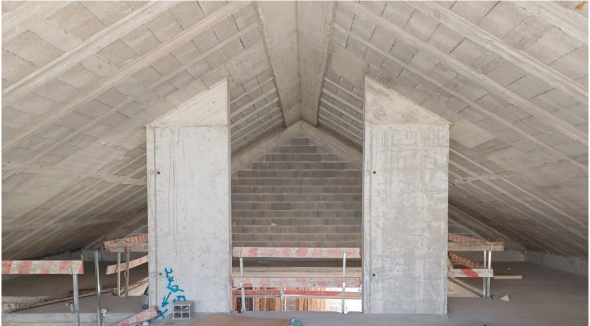
Figura 4.18 – Paredes de betão do piso 1 do Kids club onde serão instalados os difusores lineares
