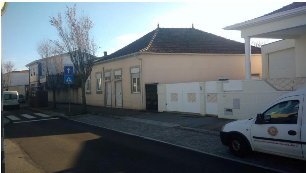
Imagem 8 - Fachada Original Habitação Existente
