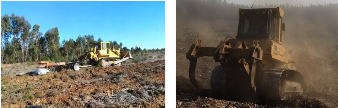
FIGURA 101: Exemplo de equipamentos utilizados na implementação da área de ensaio (imagem da esquerda exemplo de Buldózer a rebocar dois corpos de grades de discos e imagem da direita Buldózer com alfaia de 2 dentes).
