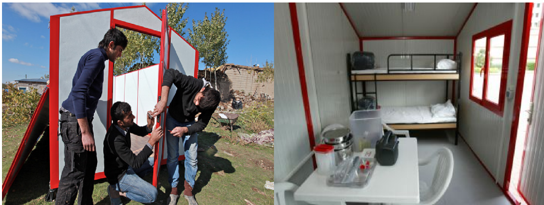
Fig. 118 - Montagem dos componentes e imagem do interior
