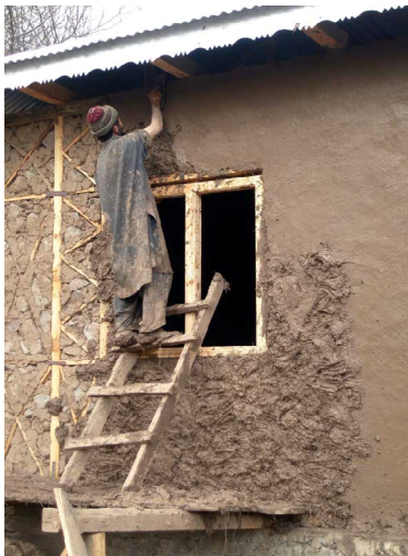
Fig. 112 - Edifícios construídos com materiais locais e técnicas tradicionais.
