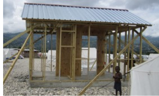
Fig. 137 - Pormenor da estrutura de Madeira
