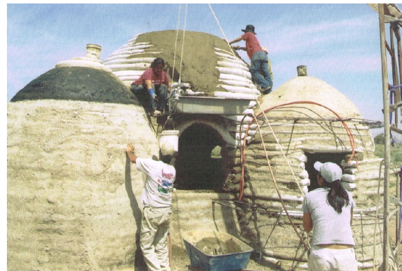
Fig. 60 - Abrigos construídos com o sistema do superadobe de Nader Khalili.
