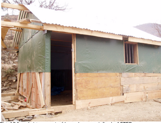
Fig. 104 - abrigos construídos sob supervisão da ACTED, um com materiais locais, outro com lonas da USAID.
