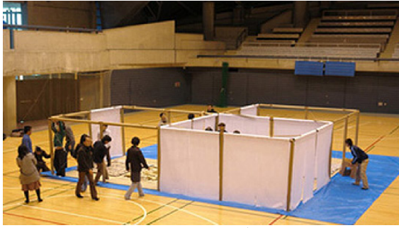
Fig. 55 - implantação do sistema de divisórias de Shigeru Ban num pavilhão desportivo.
