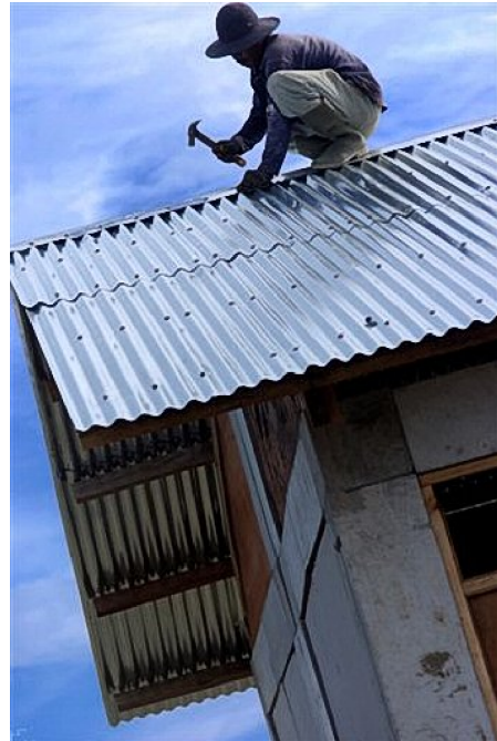
Fig. 85 - Construção do abrigo da IOM, através de mão-de-obra local.
