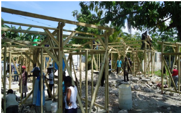
Fig. 144 - Pormenor da estrutura.
