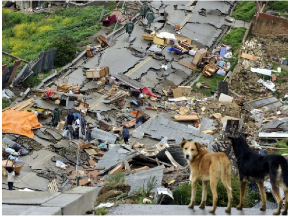
Fig. 11 - Consequências do deslizamento de terras
