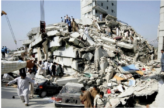
Fig. 96 - Destruição das Margalla Towers - 8th Oct 2005 , Islamabad
