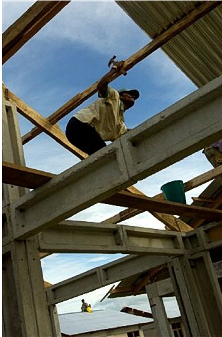
Fig. 84 - finalizando a cobertura
