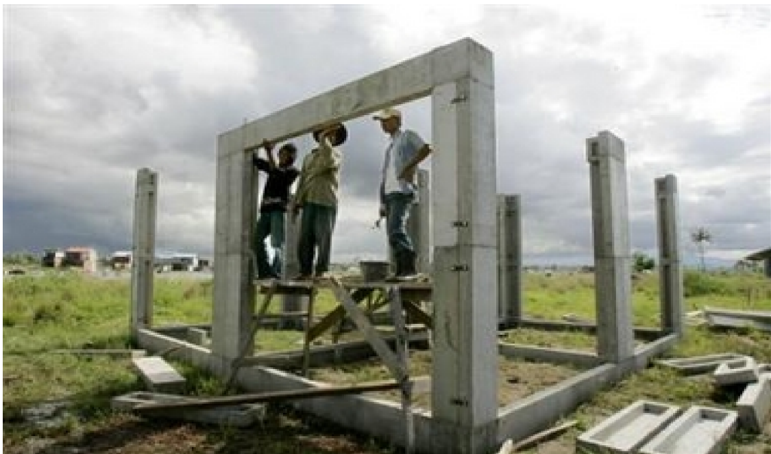
Fig. 86 - montagem da estrutura
