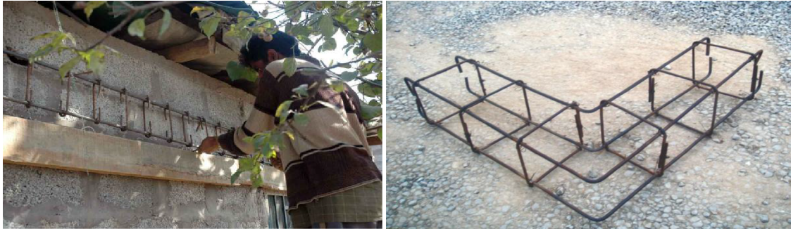
Fig. 115 - Material de reforço para reconstrução ferro, alvenaria/Construção tradicional
