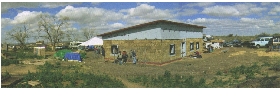
Fig. 61 - Construção permanente segundo técnicas tradicionais, a hopi nation elder home.
