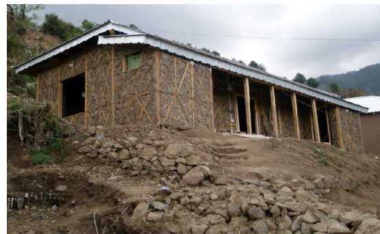
Fig. 111 - Reconstrução antissísmica com técnicas tradicionais
