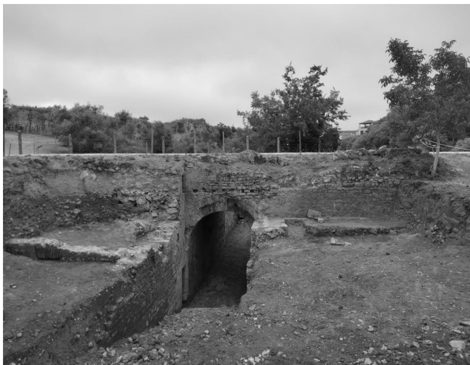
Fotografia n.º 5. Perspetiva geral do viaduto após trabalhos de escavação em 2022 (MMP, EPE).
