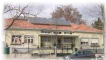
Figura 3- Fachada do Jardim-Escola de Alvalade
