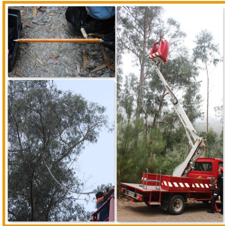
Figura 40- Destruição de ninho com recurso a plataforma elevatória
