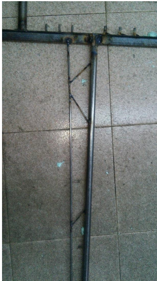
Figura 14 - Estrutura metálica de reforço da quilha
