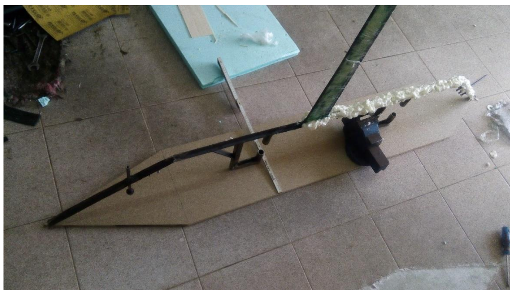
Figura 16 - Molde em madeira com a estrutura metálica da quilha
