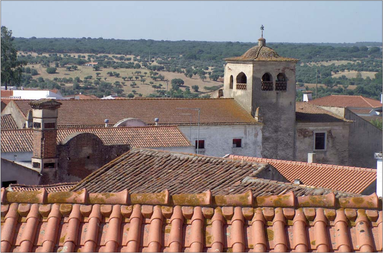
FIG. 1 – Convento de N.ª Sr.ª da Graça do Torrão. Corpo da igreja do convento e da torre-mirante anexa.
