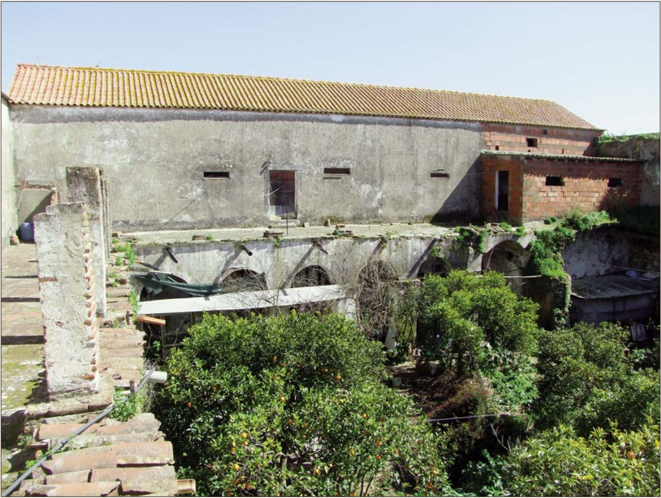
FIG. 14 – Aspecto actual do 1 andar. Em frente o dormitório. Ao canto direito da foto, no nível térreo, os restos do desaparecido refeitório.
