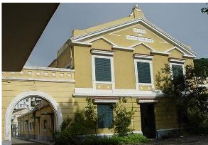
Figura 26 - Edifício das Oficinas Navais, atualmente Museu Marítimo de Macau. Foto: espólio da Revista Macau.
