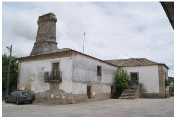
Figura 1.13 – Casa da chaminé
