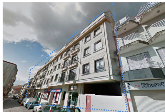
Fig. 175 - Edificación adosada Nº3 en 2013.
