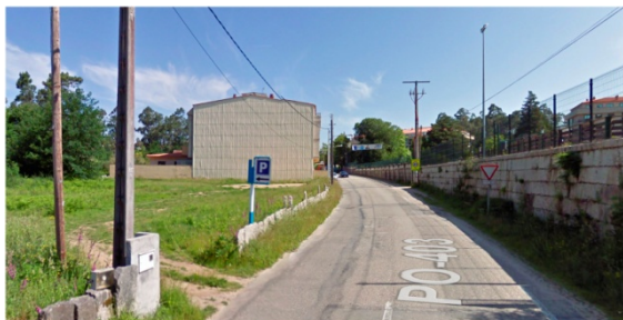
Fig. 187 - Estacionamento público nº3 en 2013.
