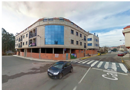
Fig. 171 - Edificación illada Nº4 en 2011.
