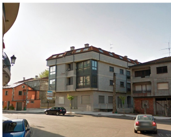
Fig. 170 - Edificación illada Nº3 en 2013.
