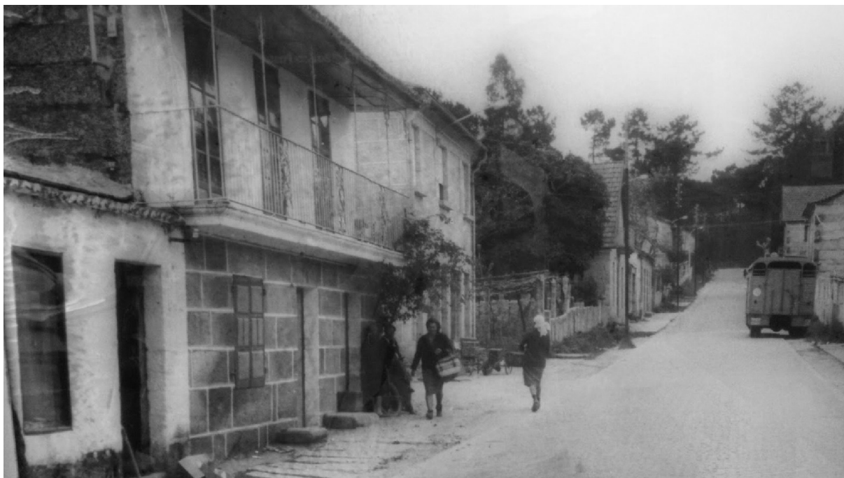
Fig. 46 - Fotografía o redor da década dos anos 1950-1960 da estrada PO-410.
