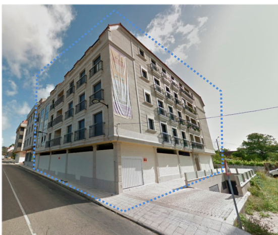
Fig. 173 - Edificación adosada Nº1 en 2013.
