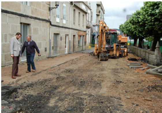
Fig. 159 - Obras na Rúa Doutor Zunzunegui.
