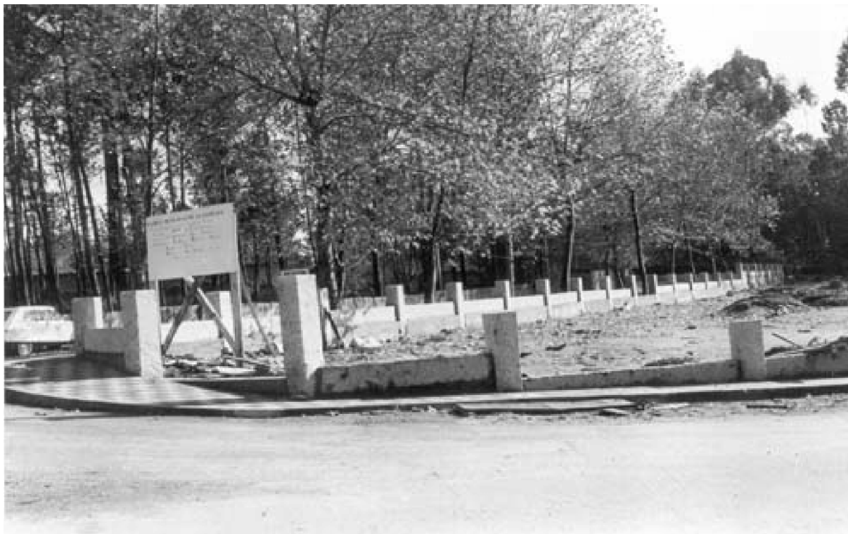
Fig. 92 - Parque Municipal da Gándara durante a súa construción.
