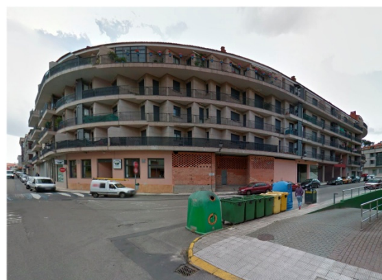
Fig. 143 - Fotografía da mazá nº2.
