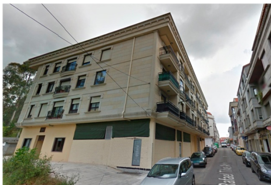
Fig. 169 - Edificación illada Nº2 en 2013.
