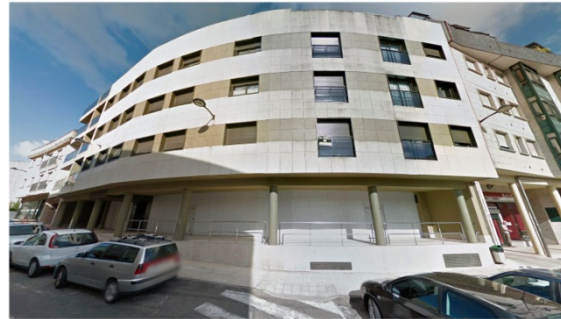
Fig. 174 - Edificación illada Nº2 en 2013.
