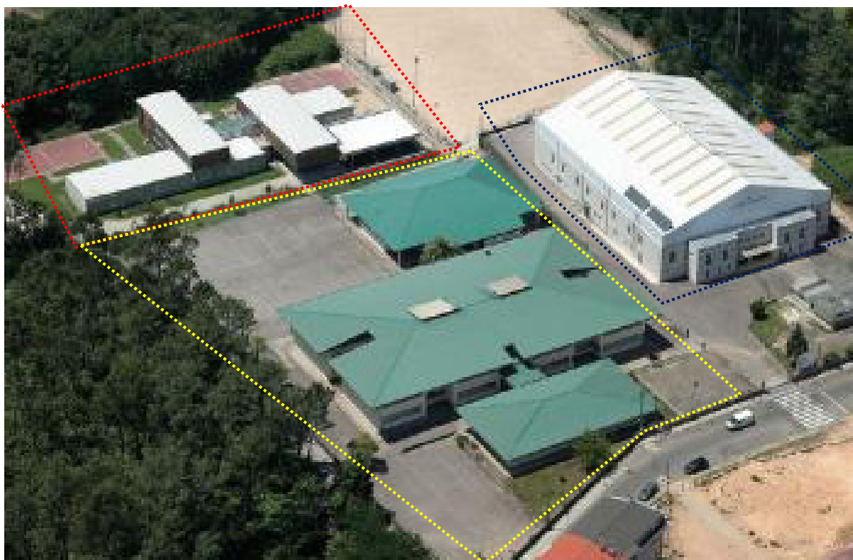
Fig. 149 - Fotografía aérea, Colexio Publico Altamira e Pavillón Municipal.
