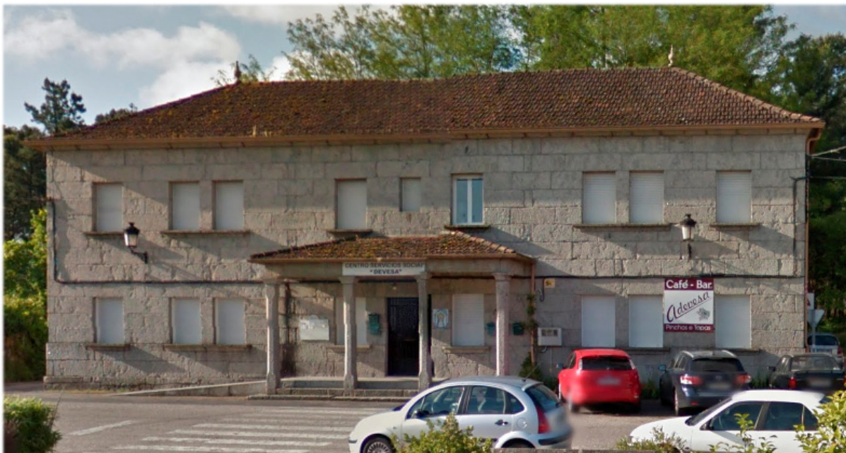
Fig. 127 - Antigo Cuartel da Guarda Civil.
