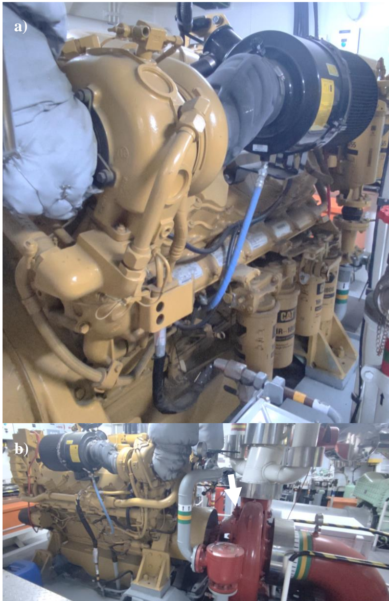
Figura 4-8 – Conjunto motobomba do sistema FiFi: a) Motor de acionamento; b) Bomba do sistema FiFi
