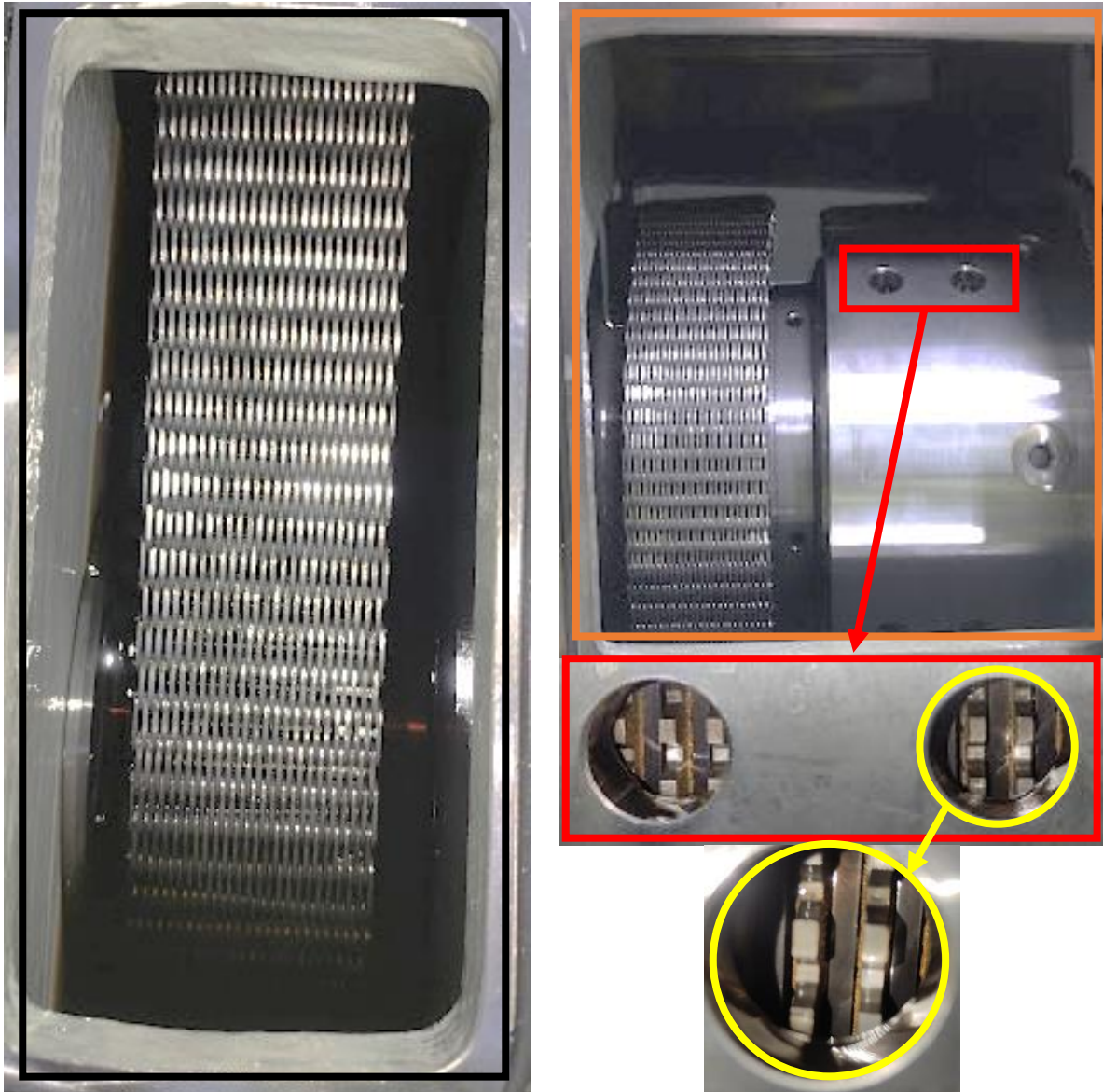
Figura 5-7 –Inspeção ao interior de uma das Embraiagens
