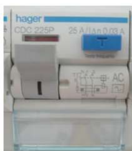
Figura 19: Disjuntor diferencial com sensibilidade de 30mA.
