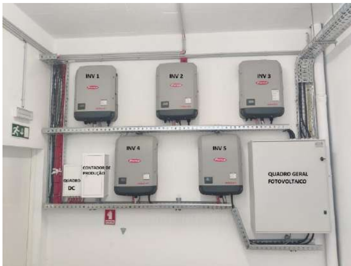
Figura 5.154 - Zona Técnica, Fumeiros Profírios.
