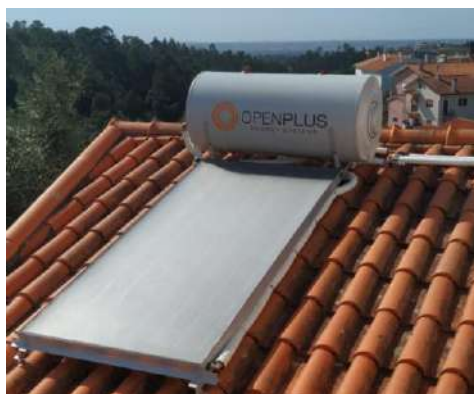
Figura 4.9 - Sistema de circulação termossifão com transferência indireta, da marca Openplus.
