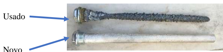
Figura 4.35 – Substituição de ânodos de magnésio.
