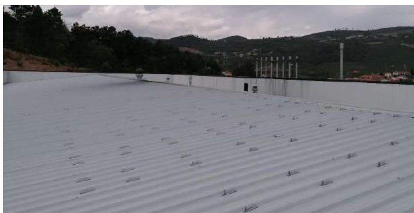
Figura 5.149 - Cobertura com a estrutura mini rail 06H, Fumeiros Profírios.
