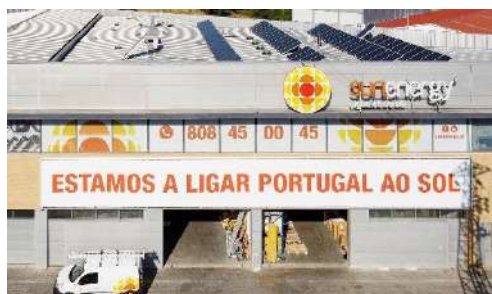
Figura 2.1 - Vista aérea da empresa, (Sunenergy, 2020)
