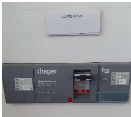
Figura 5.114 - Corte geral do quadro AC do cliente.
