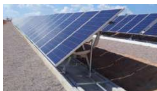
Figura 5.3 - Exemplo de seguidor de 1 eixo, (DGIT, 2018).
