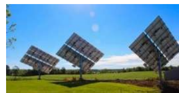
Figura 5.4 - Exemplo de seguidor de 2 eixos, (Pedro Reis, 2020).
