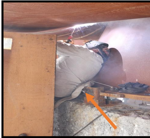
Figura 17 - Soldadura do lado exterior da virola ( postura incorreta-costas )
