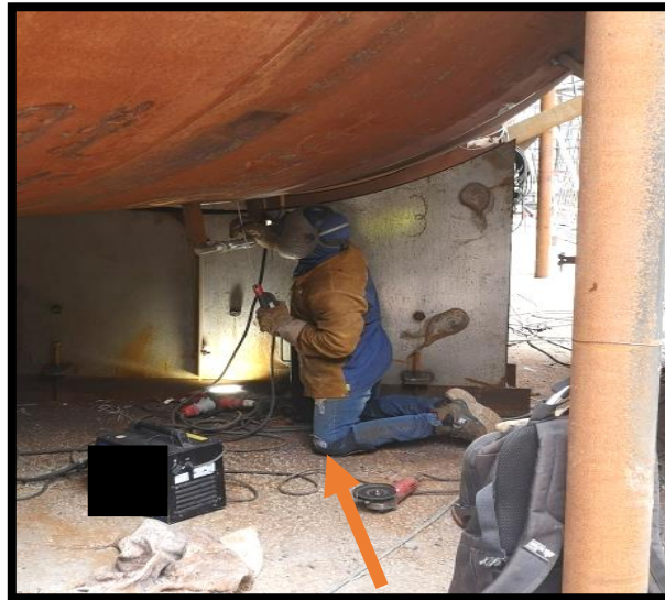
Figura 19 - Soldadura de chapas à virola (com joelhos no chão)
