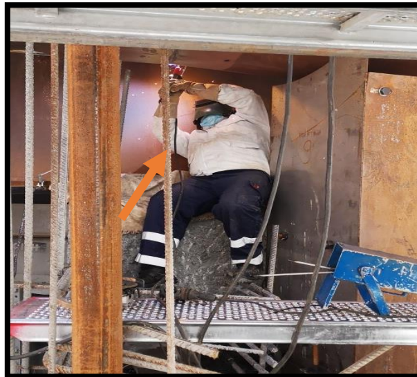
Figura 18 - Soldadura do lado exterior da virola ( esforço pelos membros superiores )
