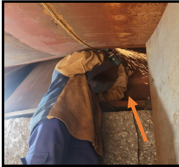
Figura 23 - Rebarbagem de soldadura (esforço dos membros superiores)
