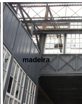
Ilustração 55| Estrutura da nave em ferro com aspecto da introdução do tijolo de burro, junto ao pátio interior, imagens tiradas no período de destruição da Fábrica Tabaqueira em Marvila.
