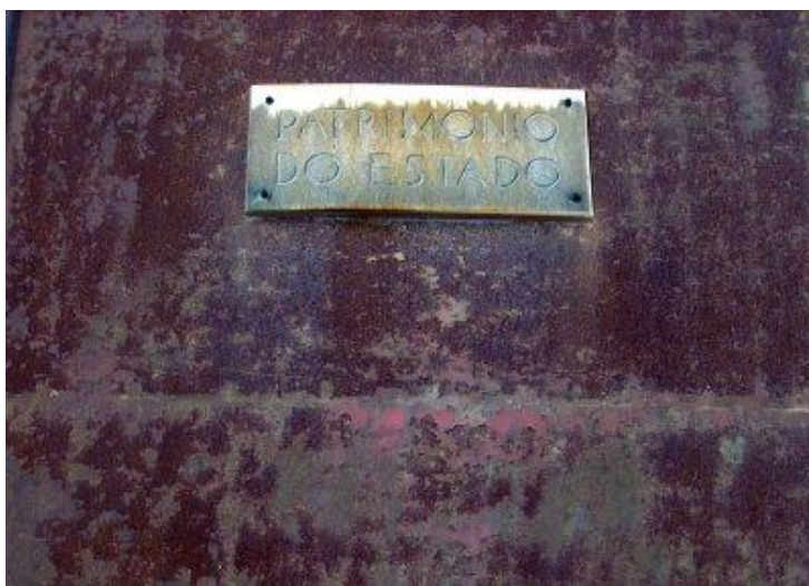
Ilustração 40| Pormenor da fachada em ferro do pavilhão principal da Fábrica da Tabaqueira, Lisboa S.O.S
