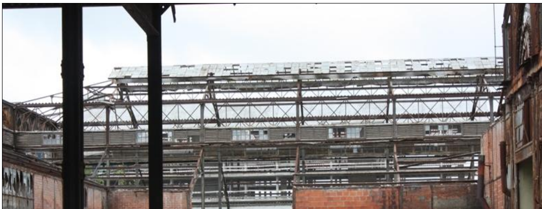
Ilustração 53| Estrutura de naves em ferro, de acordo com imagens do acto de destruição da Fábrica Tabaqueira em Marvila.
