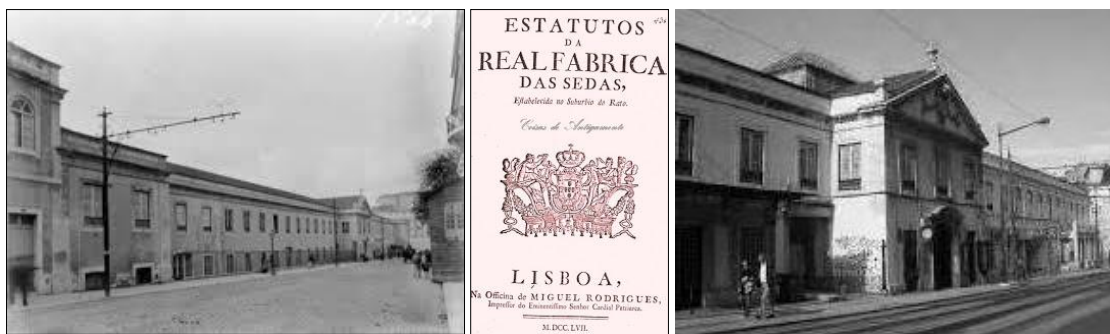
Ilustração 11 | Fachada da Real Fábrica das Sedas ao Rato em Lisboa. Fonte Imagem de autor desconhecido|
