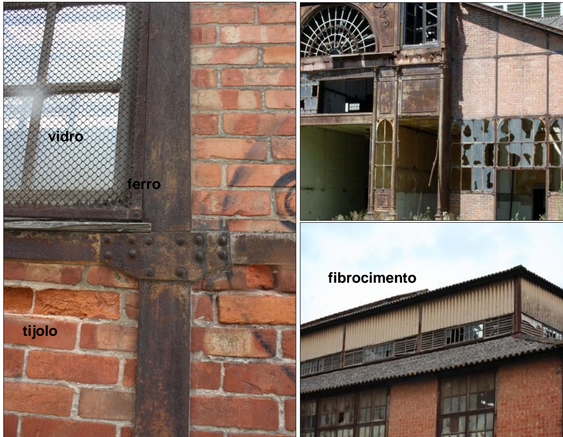
Ilustração 52| Imagens da Fábrica Industrial Tabaqueira, evidenciando os materiais utilizados. Fonte imagens retiradas no local e a última cedida por o Fotógrafo Gastão de Brito e Silva, Ruinate
