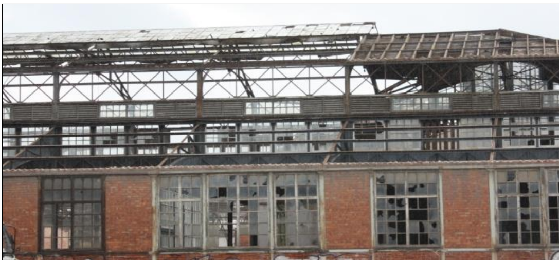
Ilustração 54| Estrutura das naves em ferro e tijolo de burro, imagens tiradas no período de destruição da Fábrica Tabaqueira em Marvila.
