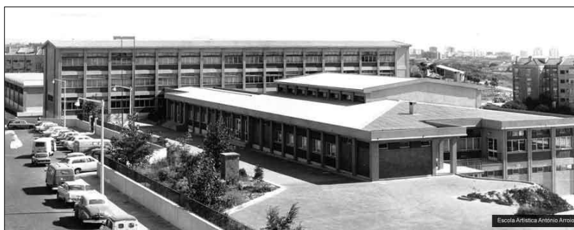
Figura 2: " Edifício escolar antes da remodelação de 2009
