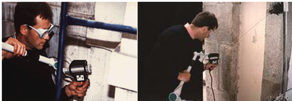
Figura 145. Limpeza a laser.
