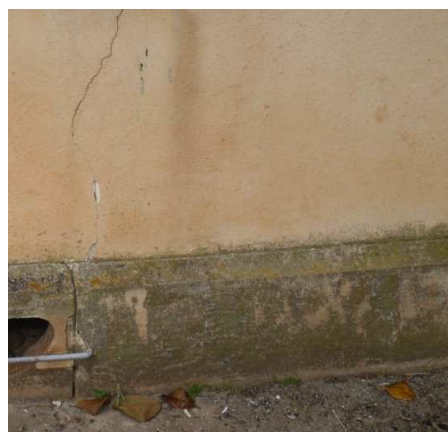
Figura 143. Alteração da pedra das fachadas do edifício.
