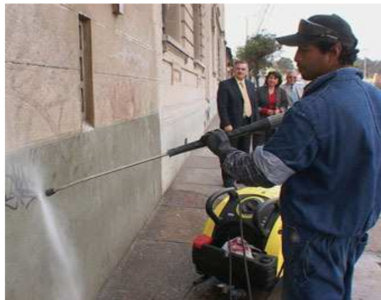
Figura 178. Limpeza a Microjacto de precisão de partículas abrasivas.
