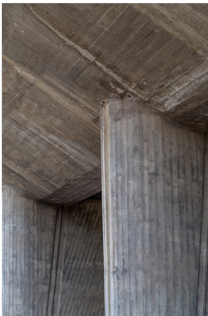
Fig. 49. Pormenor betão aparente no piso térreo, Unité d'Habitation , Le Corbusier, 1945
