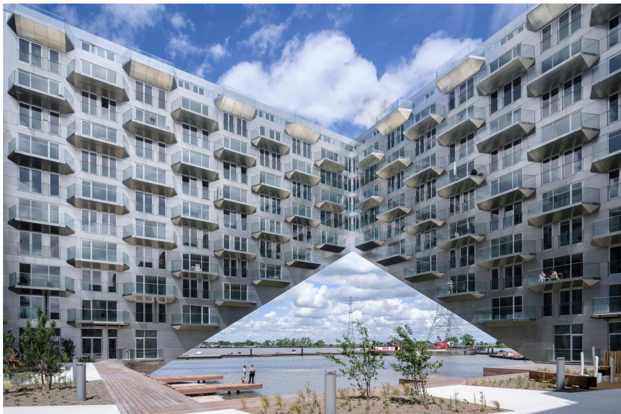
Fig. 74. Vista do pátio para a fachada interior Sluishuis , BIG + Barcode Architects, 2022
