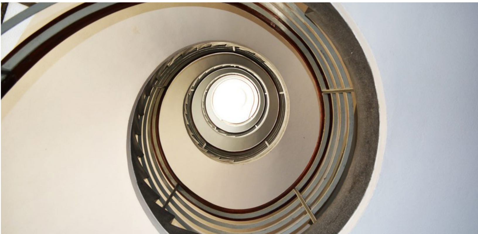
Fig. 43. Escadas do Bloco da Carvalhosa, Arménio Losa e Cassiano Barbosa, 1945
