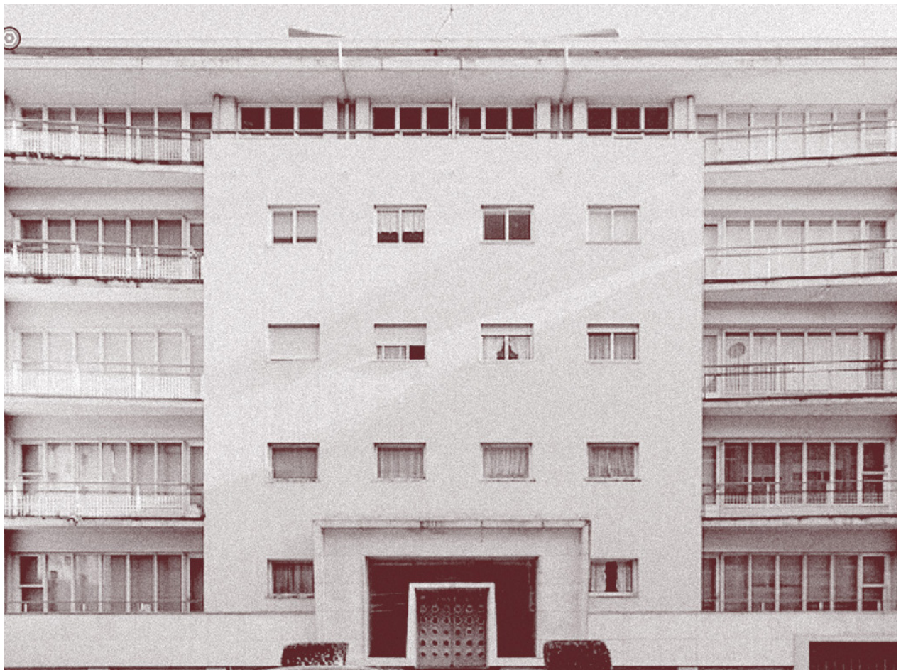
Fig. 36. Fachada do Bloco da Carvalho, Arménio Losa e Cassiano Barbosa, 1945
