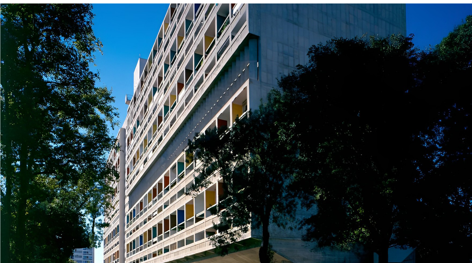
Fig. 45. Fachada da Unité d'Habitation , Le Corbusier, 1945
