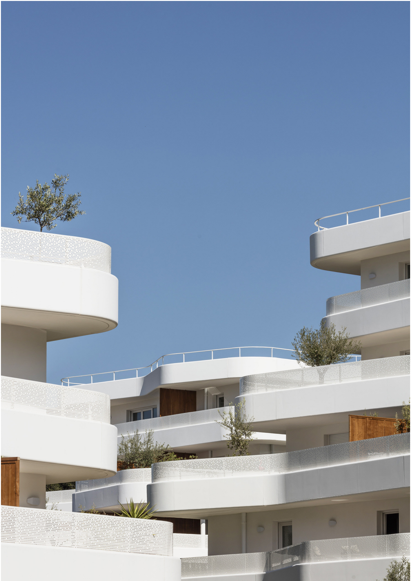
Fig. 26. La Crique , PietriArchitectes, 2018
