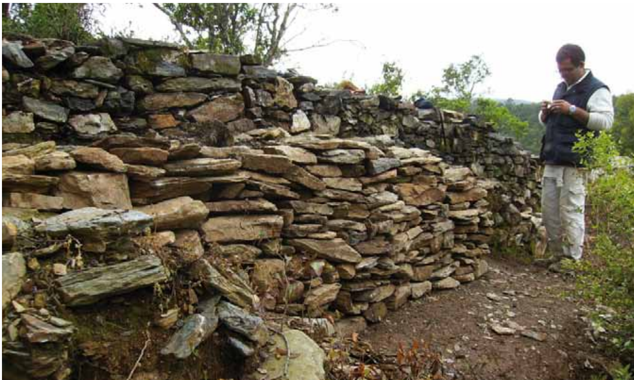
Resultado final após a elevação do muro de proteção.
