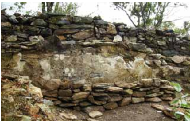
Início da construção do muro de proteção.
