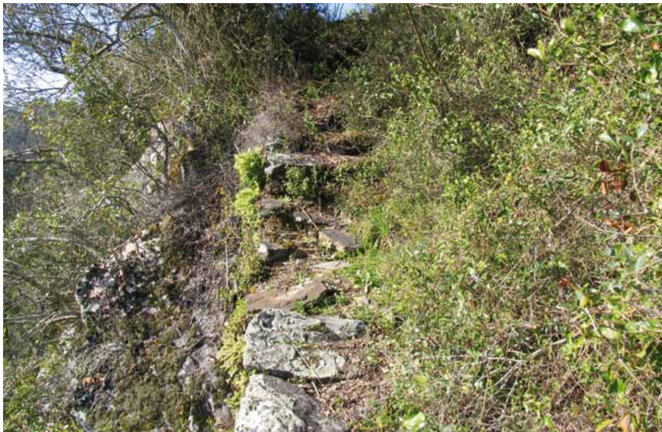
Vestígios dos degraus existentes em 2007.
