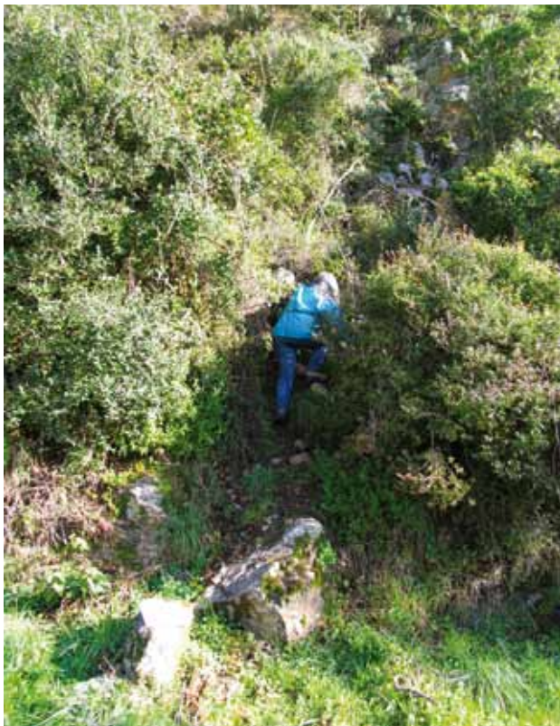
Acesso à plataforma da Torre do Castelo de Aguiar de Sousa em 2007.
