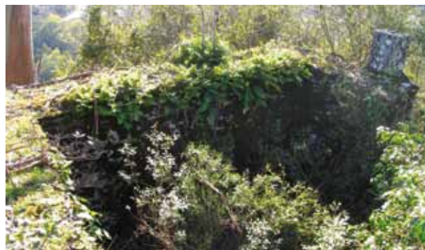
Torre do Castelo de Aguiar de Sousa antes dos trabalhos de limpeza.
