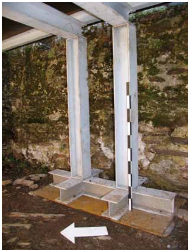
Estrutura do varandim da Torre.
