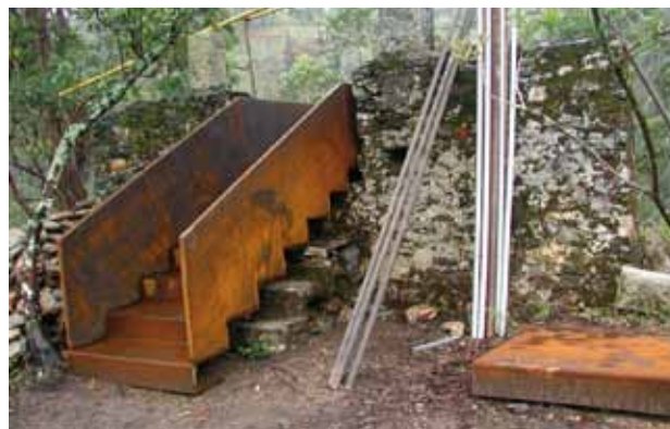
Estrutura de acesso ao varandim.
