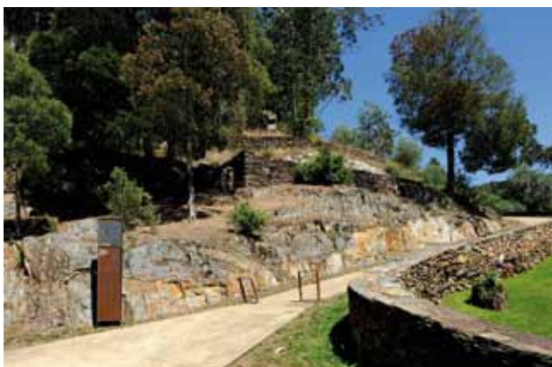
Pavimento destinado ao acesso pedonal em saibro/solo-cimento.
