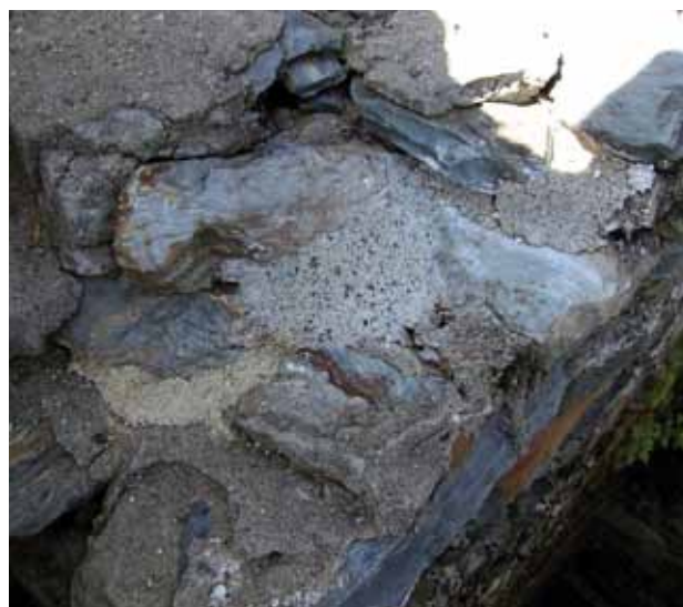
Pormenor dos testes de argamassas.
