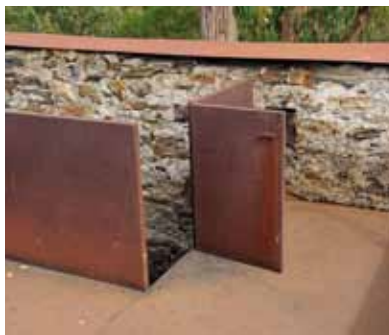
Varandim da Torre do Castelo de Aguiar de Sousa.
