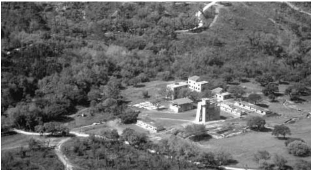
Ilustração 30 - Centro de Formação e Treino no Combate em Áreas Edificadas
