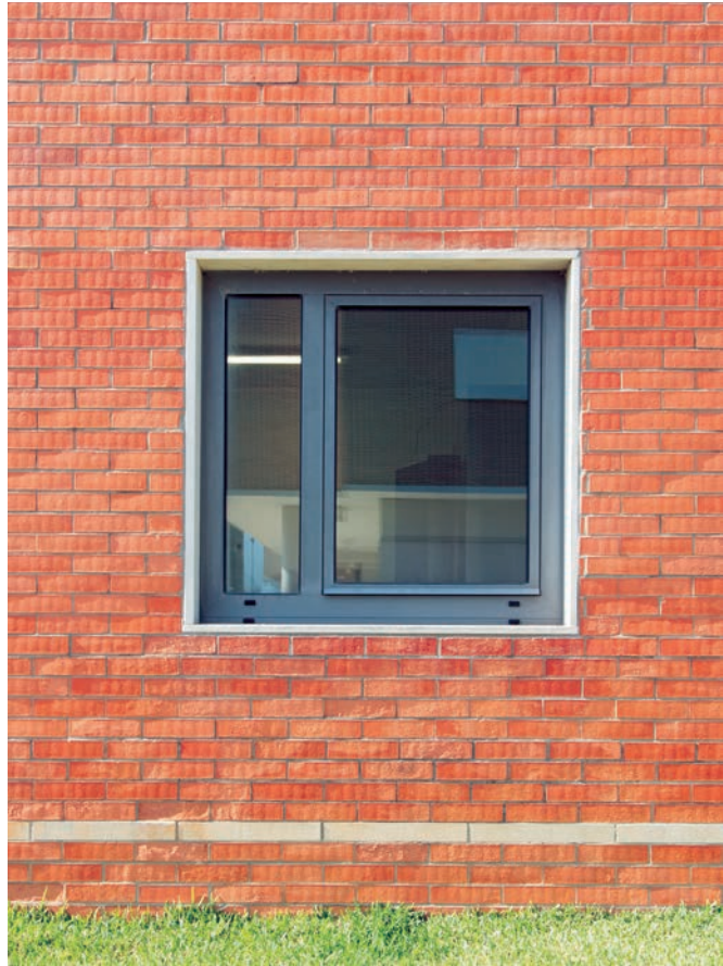
Figura 57 • Como se pode verificar, a janela está alinhada com as fiadas verticais do tijolo, o que prova a existência do estudo de modulação vertical. Note-se, no entanto, a ausência de um estudo de modulação horizontal. Nota: a caixilharia não é a original. Figura 58 • Departamento de Biologia – Projecto de Execução, Corte/alçado parcial L-M. Figura 59 • Departamento de Biologia – Projecto de Execução, Desenho n.º 17: Pormenores; Cortes verticais das fachadas. Figura 60 • Repare-se nas padieiras das portas.
