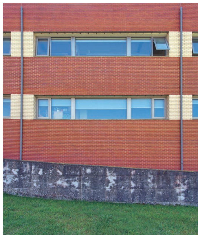
Figura 48 • Pormenor dos vãos exteriores do edifício da Expansão do Departamento de Biologia.
