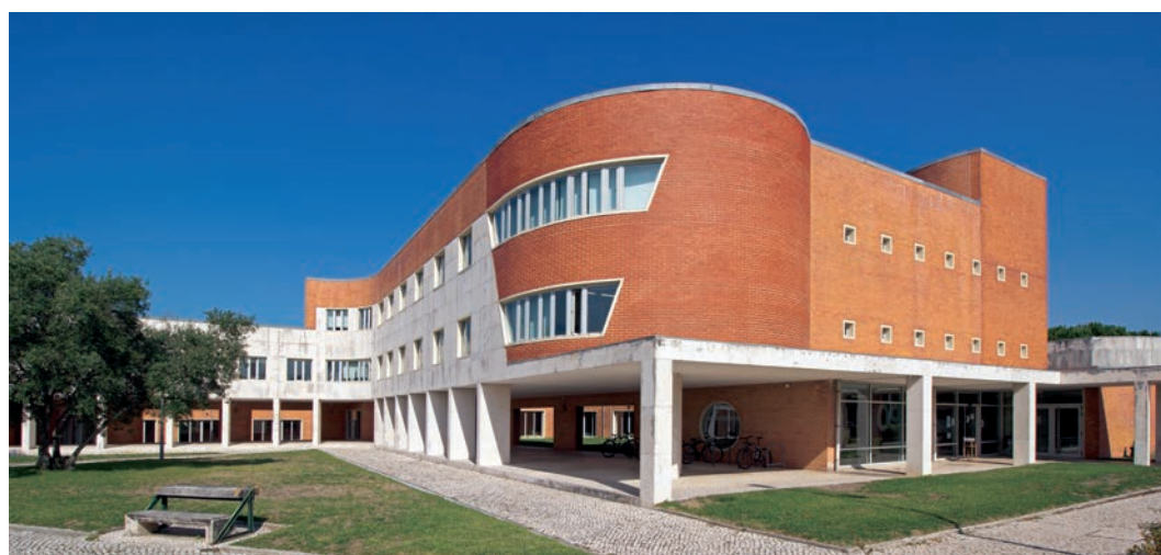
Figura 5 • Departamento de Engenharia Cerâmica e do Vidro. Nota: Alguns troços do tijolo à vista, os rufos, as caixilharias e o remate metálico entre estas e o tijolo constituem alterações ao edifício original.
