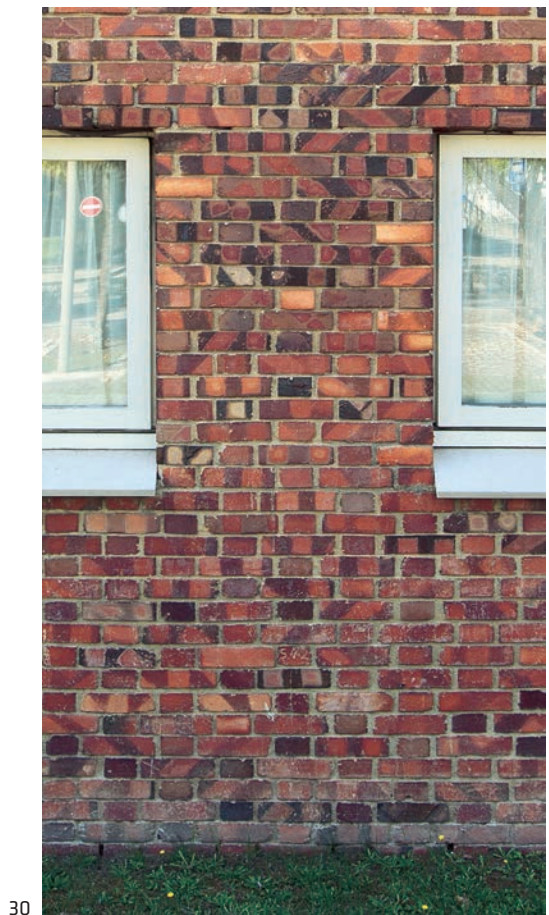
Figura 28 • Pormenor da fachada do Departamento de Engenharia Mecânica. Figura 29 • Residências de Estudantes – Projeto de Execução, Desenho n.º 26: Vãos e aparelhos de tijolo. Figura 30 • Os dois tipos de aparelho do tijolo.
