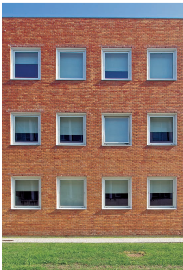
Figura 62 • Fachada parcial do Departamento de Gestão.
