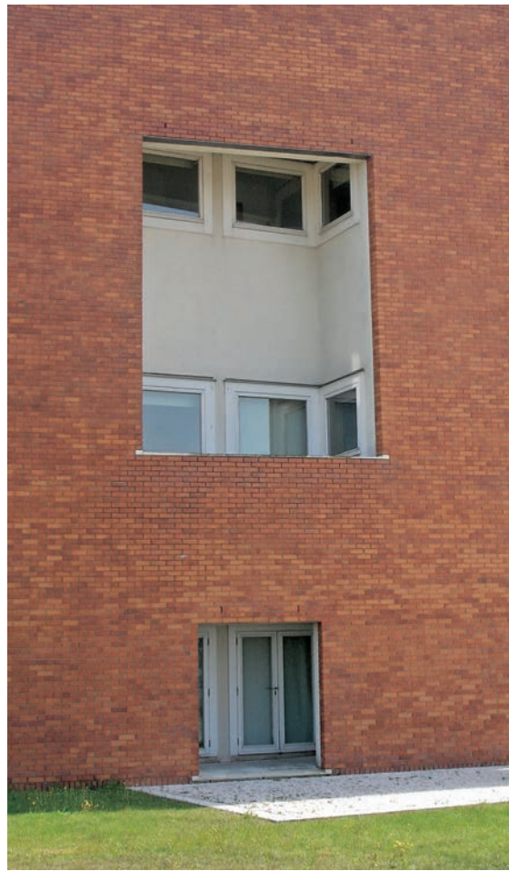
Figura 19 • A Biblioteca. Figura 20 • Biblioteca: Centro de Informação Tecnológico – Projeto de Execução, Desenho n.º 27: Modelação do revestimento exterior. Repare-se, na parte inferior do desenho, no esquema de assentamento do tijolo preconizado, realizado em função do espaçamento entre os elementos estruturais. Figura 20a • Repare-se nos tijolos e soleira nos extremos da reentrância da fachada.
