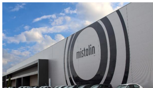
Figura 1.1- Instalações da Mistolin, S.A, em Vagos.
