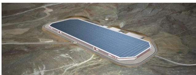
Figura 30 - Fábrica em Sparks, Nevada, com um telhado coberto de painéis solares
