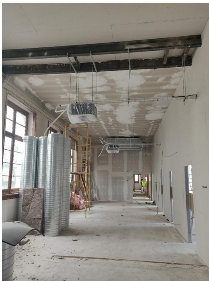
Figura 4.5 – Instalação de unidade e componentes AVAC a uma cota elevada no edifício TUMO Coimbra
