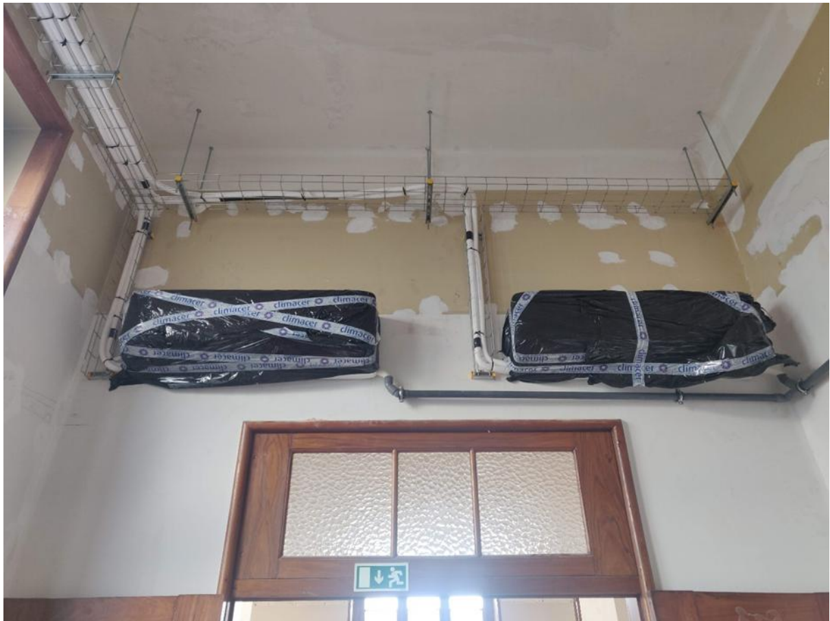
Figura 4.4 - Unidades murais instaladas a uma cota elevada no edifício TUMO Coimbra
