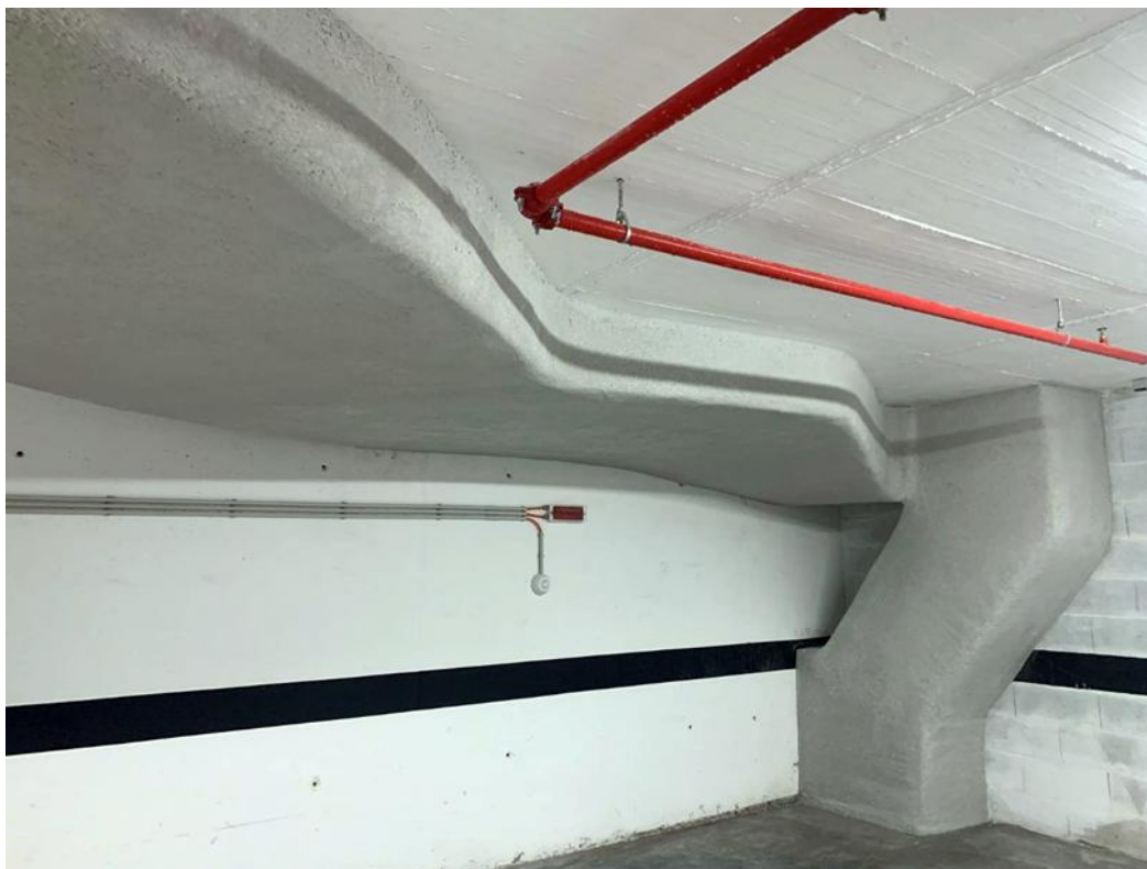
Figura 3.26 - Conduatas com aplicação de proteção corta-fogo pelo exterior
