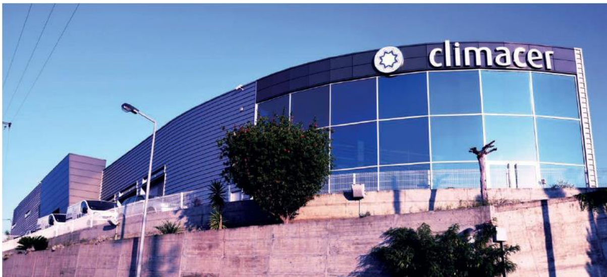
Figura 2.1 - Fachada da empresa Climacer Lda., em Trouxemil
