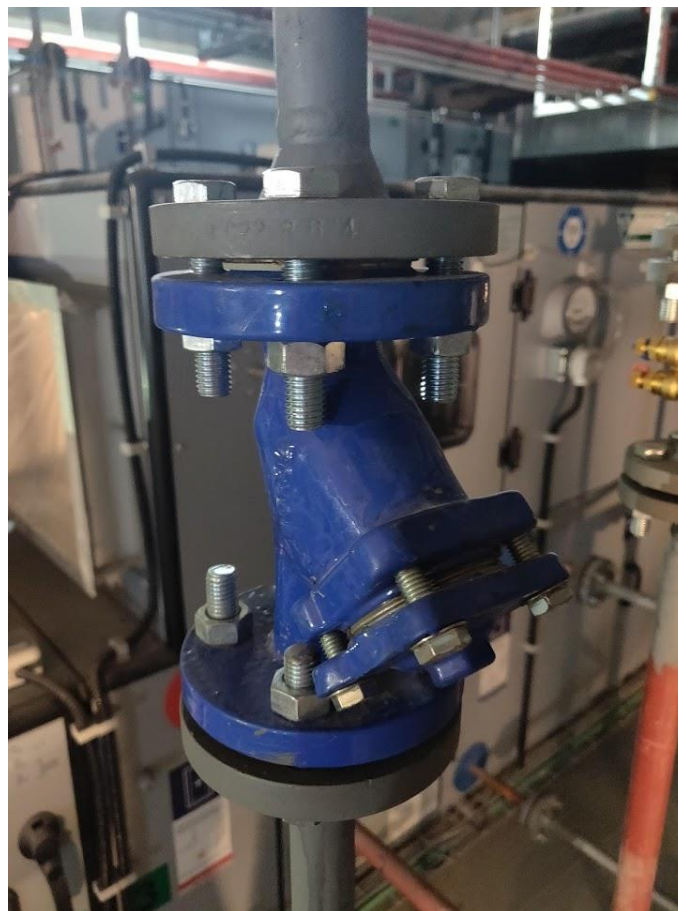
Figura 5.24. Filtro do tipo “y” na alimentação de uma UTA do HCT
