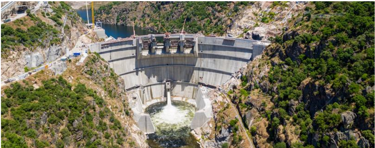
Figura 2.2 - Aproveitamento Hidroelétrico de Foz Tua
