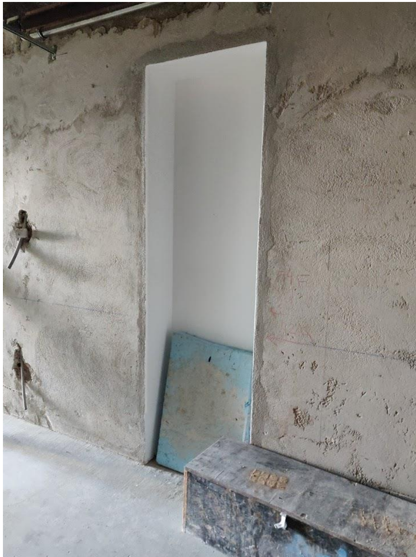
Figura 5.14. Nicho onde se irá localizar o registo RD.18 no HCT
