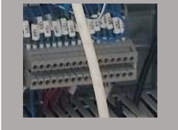
Figura 108 - Disposição do Barramento de Outputs
