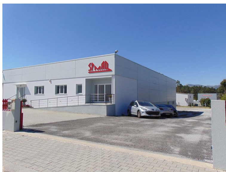
Figura 1 - O primeiro de dois pavilhões da empresa
