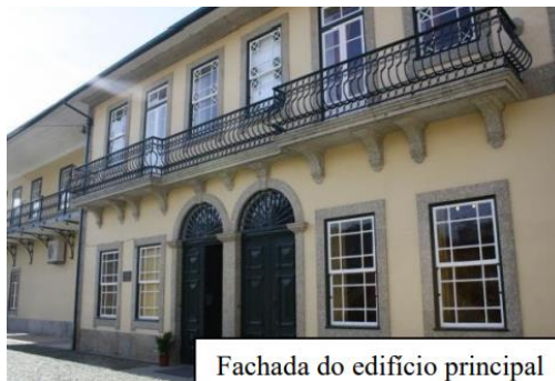
(Imagem 3 – Fachada do edifício principal da AMCP)
