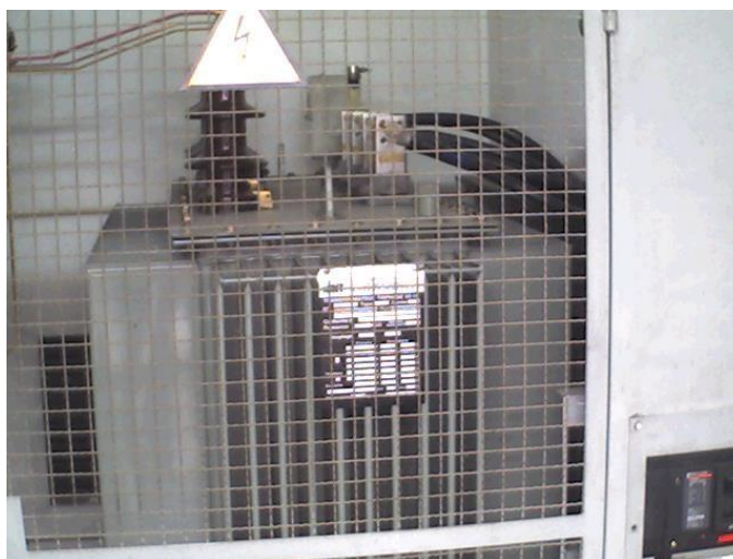
Figura 3,3 - Transformador com Potência nominal de 630 kVA
