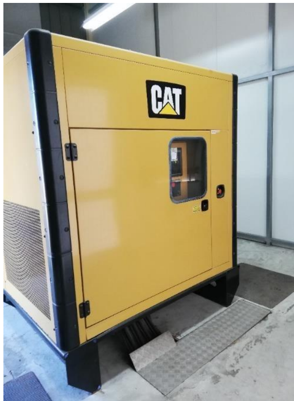
Figura 3.15-Gerador de emergência
