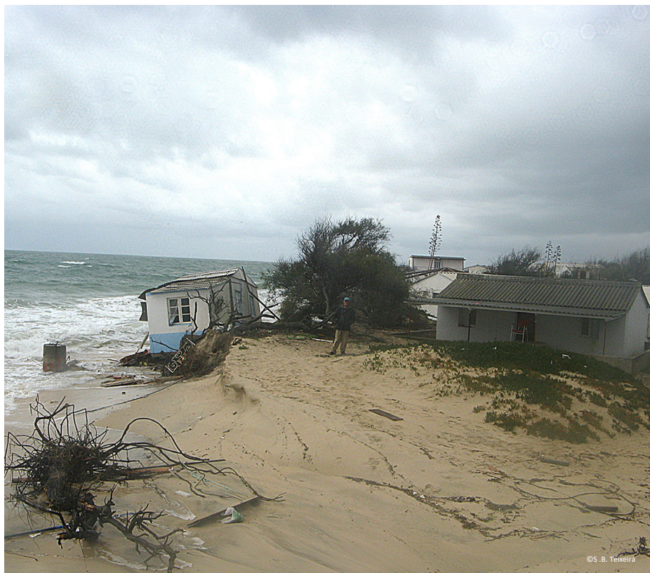
Figura 18. Erosão da fachada oceânica e galgamento da duna e raso de barreira da Ilha da Armona, com destruição de edifícios construídos na praia da Fuzeta (tempestade de 28 de fevereiro de 2010).
