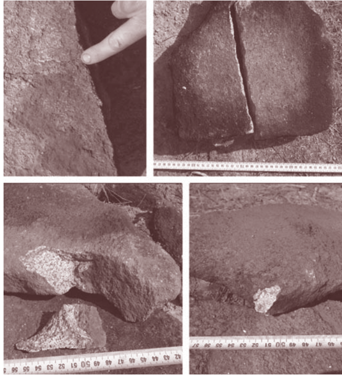
fig. 6 Exemplos de fissuração rectilíneas e levantamentos acidentais obtidos nas lajes de granito utilizados nas estruturas experimentais realizada em 2008.
