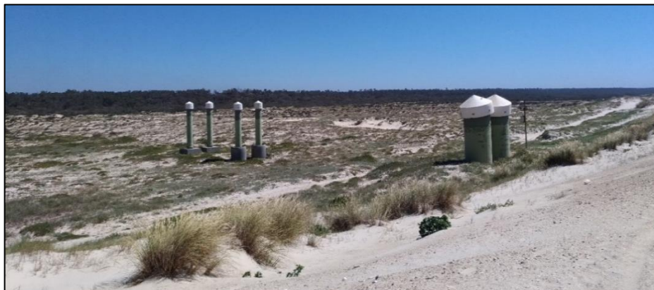
Figura 18: Poços verticais da CELBI junto a dunas primárias na MNU
