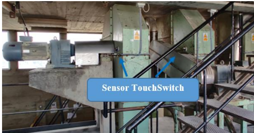
Figura 21 - Topo das Noras Piso 14
