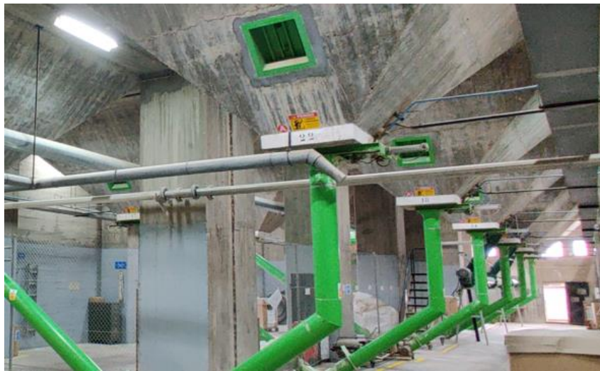
Figura 23 - Parte Inferior dos Silos no Piso 0
