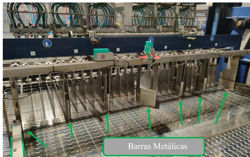
Figura 44 - Alinhamento das Garrafas na Engradadora
