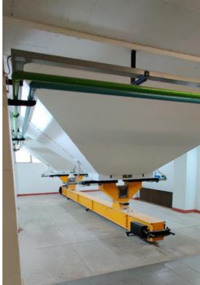
Figura 24 - Parte Inferior dos Silos A e B Malteria
