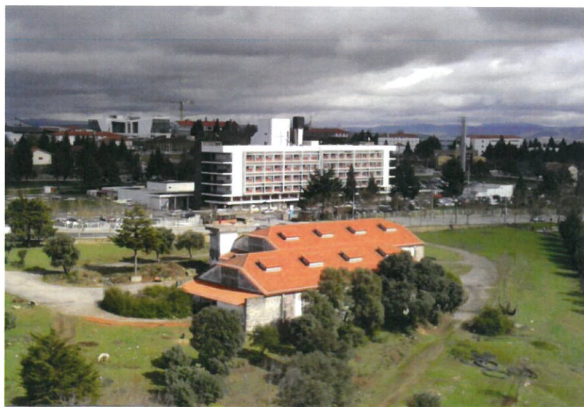
Fig. 52 – Vista Geral do Centro Hospitalar do Nordeste, Bragança
