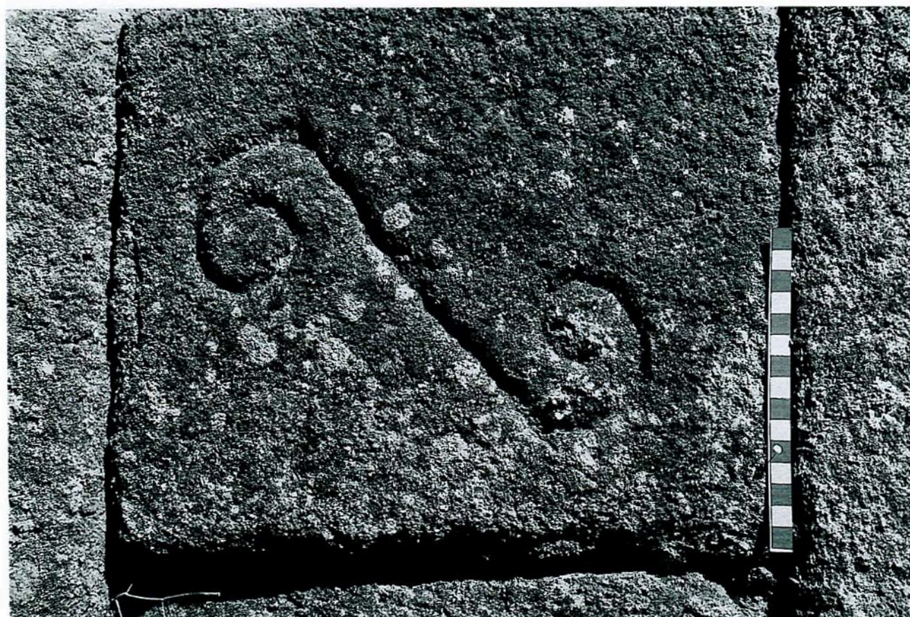
Foto 6 – Pormenor da sigla mais gravada nas pedras de aparelho na Igreja de Santa Maria – Castelo de Numão
