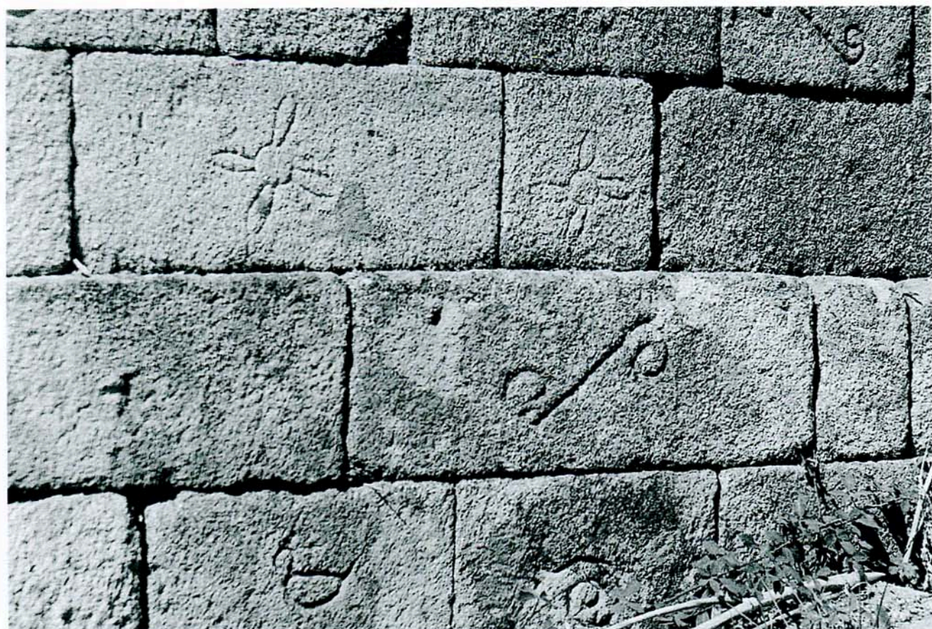
Foto 5 – Algumas das siglas ainda visíveis na parede exterior Este da Igreja de Santa Maria – Castelo de Numão
