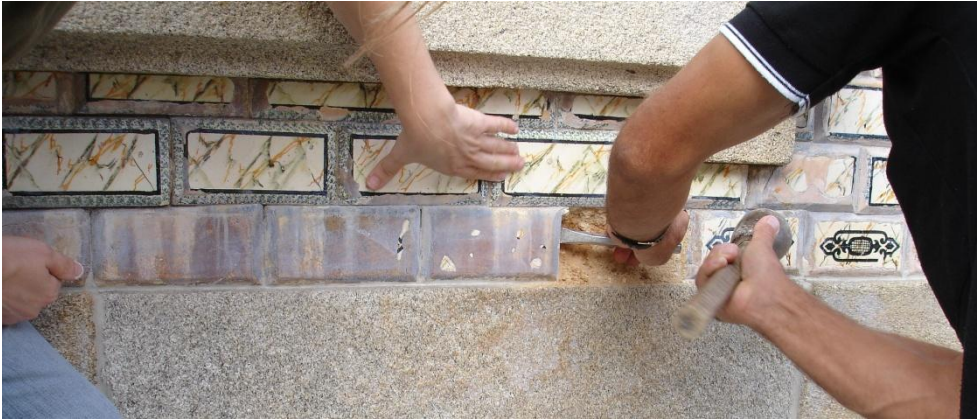
Remoção dos azulejos praticamente sem vidro, para substituição
