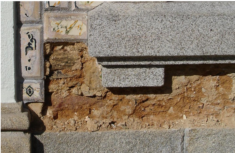
Após remoção da argamassa de emboço
