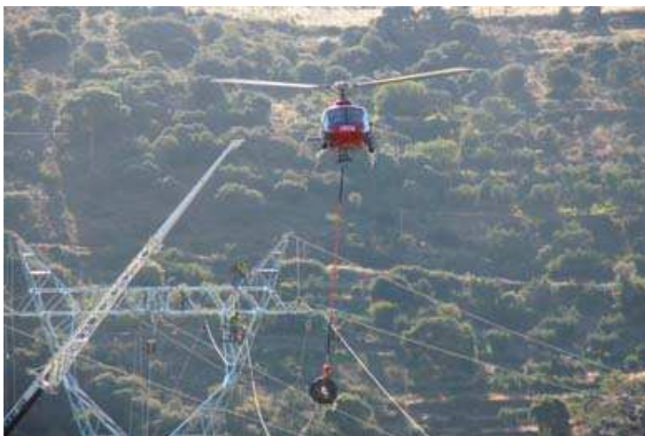
Figura 5.1 – Foto da construção de linhas MAT (E.I.P., 08/12/2012).
