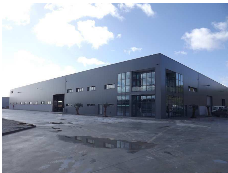
Figura 5.4 – Foto da nova fábrica de estruturas metálicas da E.I.P. (E.I.P., 08/12/2012).
