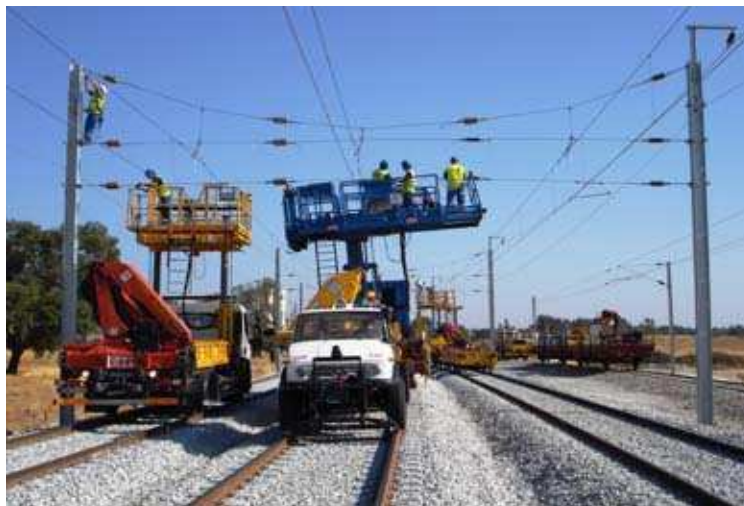
Figura 5.3 – Foto de um serviço de manutenção/conservação de catenária (E.I.P., 08/12/2012).
