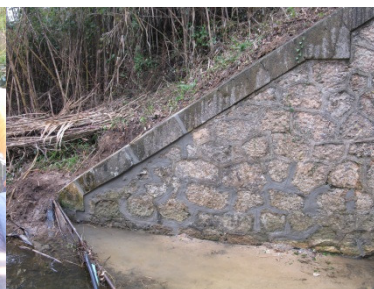
c) Refechamento de juntas de alvenaria
