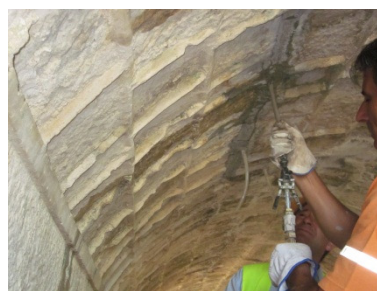
b) Injeção de calda no arco de alvenaria
