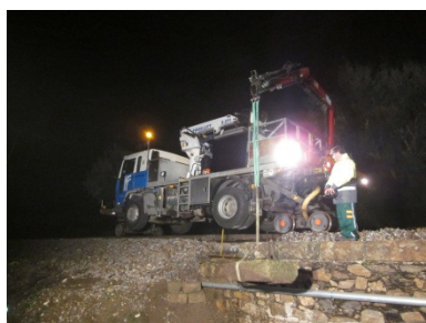
a) Recolocação de blocos de alvenaria
