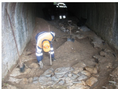
a) Reparação da Laje de embasamento
