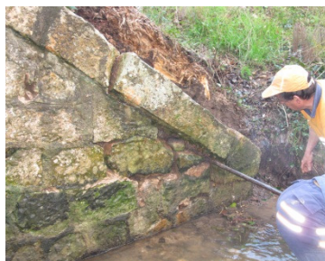
b) Reposição de elementos de alvenaria
