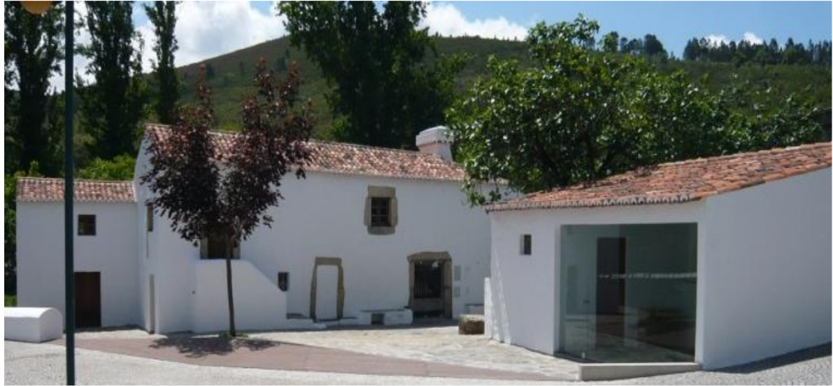
Figura 1- Edifício Moinho da Cova na Portagem
