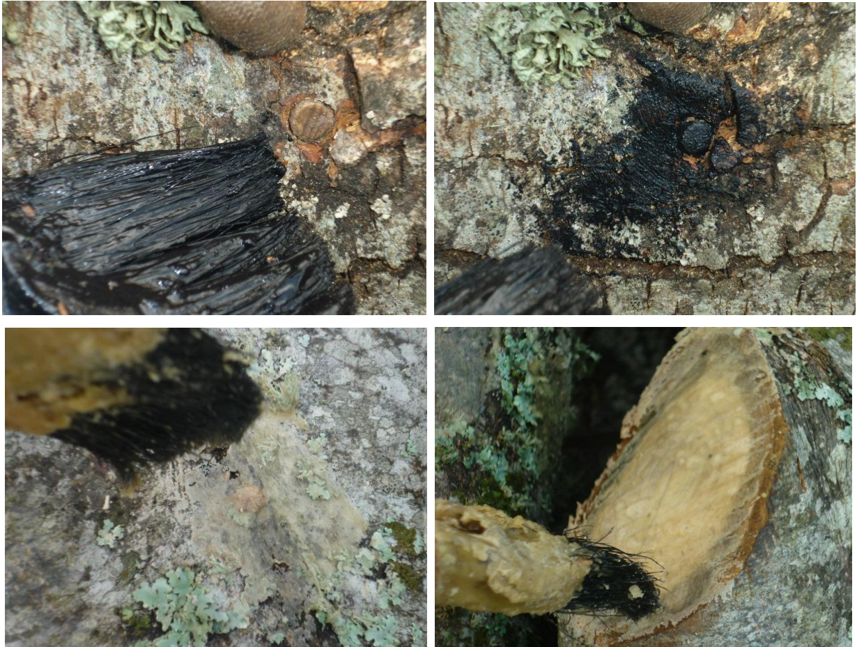
Figura 43, 44, 45 e 46- Colocação de isolador nos furos com as cavilhas
