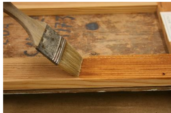
Figura 48 - Aplicação de Cuprinol® anti-caruncho para imunização do suporte
