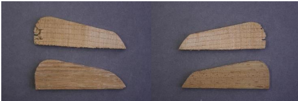
Figura 71 – As duas novas palmetas (em baixo), reproduzindo o tamanho e desenho das palmetas originais a substituir (em cima)
