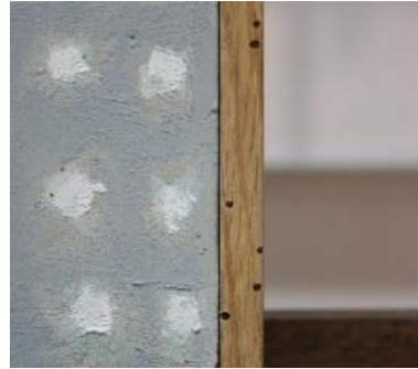
Figura 37 - Orifícios de saída de insetos xilófagos na moldura
